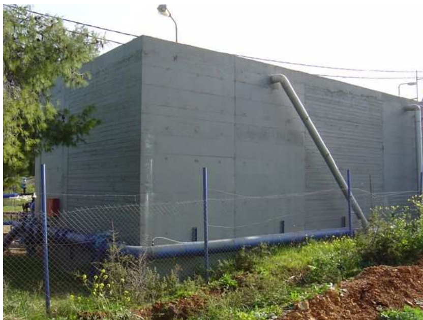
Εικόνα 12 Δεξαμενή συγκέντρωσης νερού από οπλισμένο σκυρόδεμα στο Ταχυδιυλιστήριο Οινοφύτων (Πηγή: ECOTECH ΕΠΕ)
