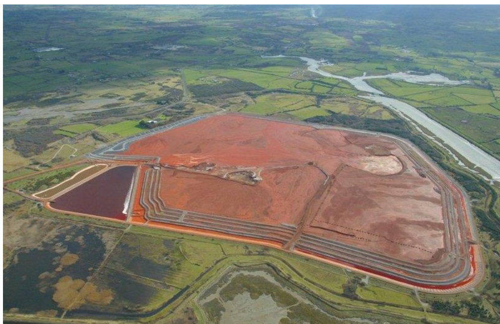
Εικόνα 7. Χώρος απόθεσης βωξιτικών καταλοίπων, Aughinish, Ιρλανδία.
