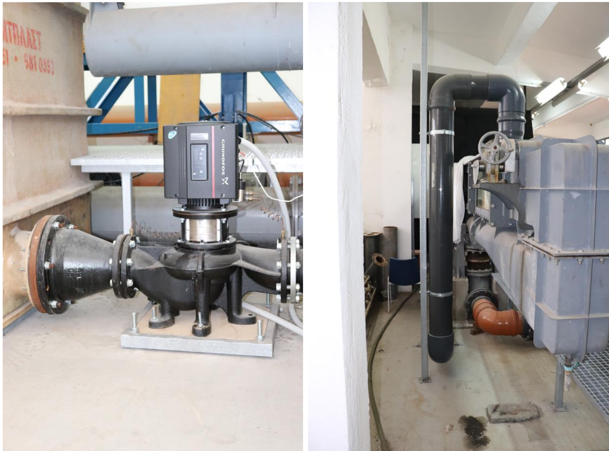
Εικόνα 4.2 Αντλία και αντικραδασμικός σύνδεσμος (αριστερά), αγωγός μεταφοράς νερού - είσοδος στη διώρυγα (δεξιά).
