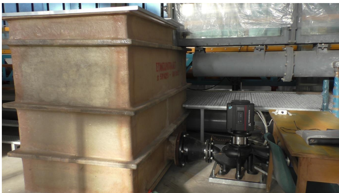
Εικόνα 4.1 Δεξαμενή νερού τροφοδοσίας της διώρυγας.
