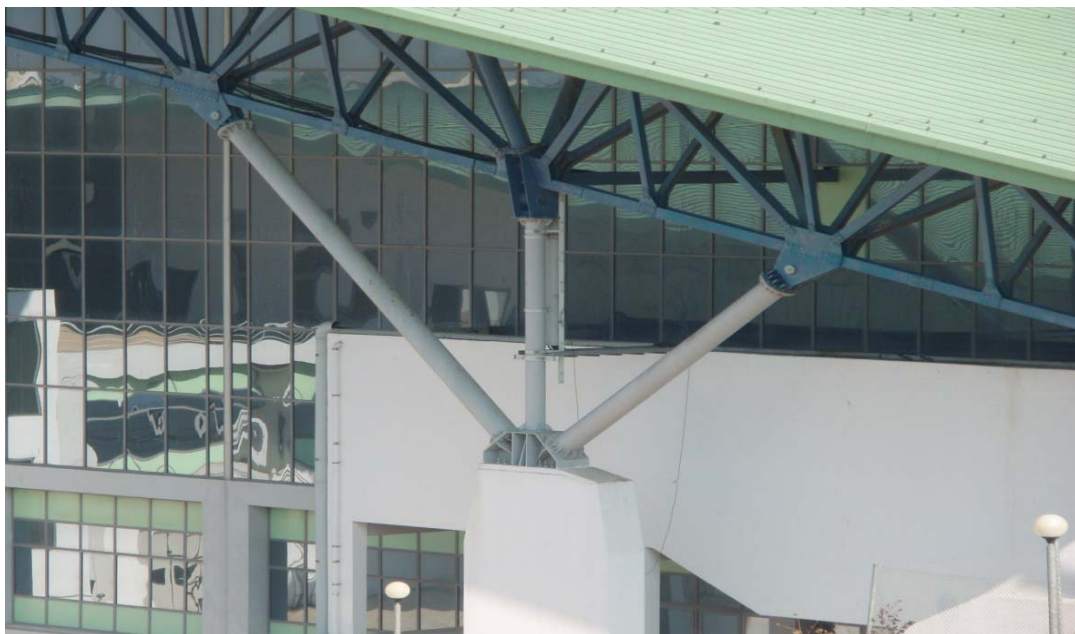
Εικόνα 1.6: Υποστύλωμα πλαισίου
