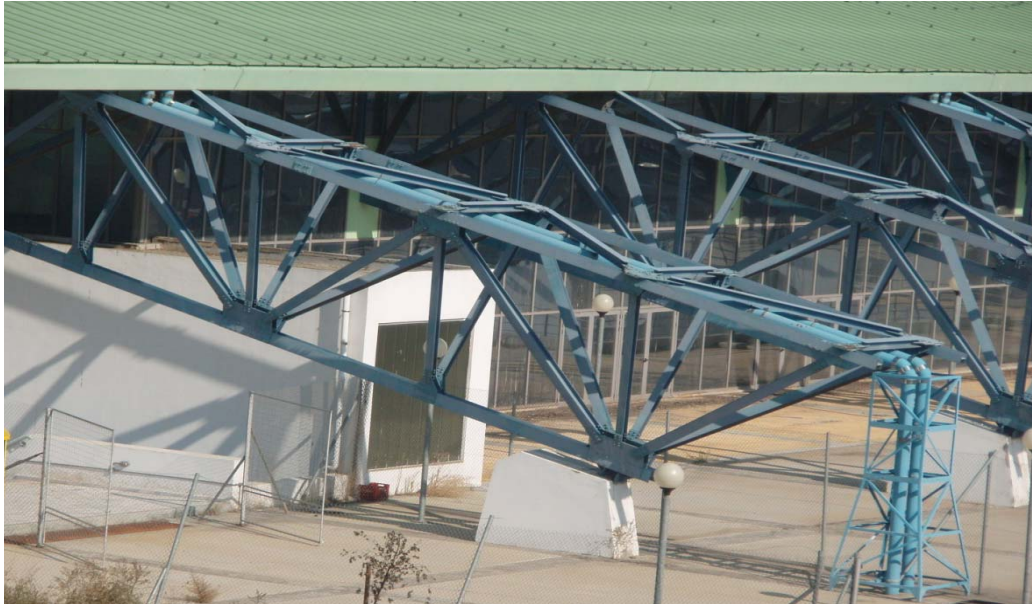
Εικόνα 1.7: Στήριξη στεγάστρου
