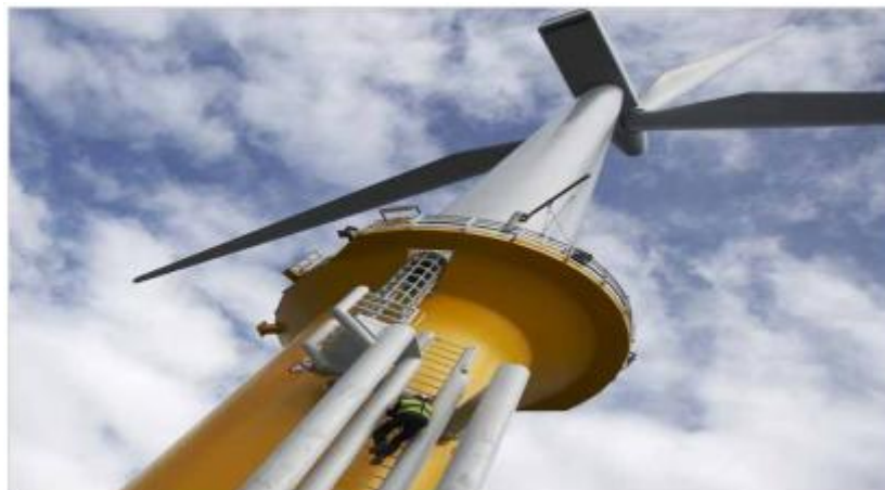
Εικόνα 3.6: Πρόσβαση σε υπεράκτια ανεμογεννήτρια από τη θάλασσα, 2 (Πηγή: EWEA, 2009)
