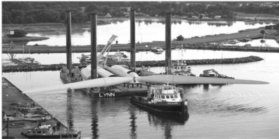
Εικόνα 5.41: Μεταφορά προσυναρμολογημένου στροφέα (70 μέτρα διάμετρος) για τοποθέτηση στο ΘΑΠ Yttre Stengrund στη Σουηδία (Πηγή: Γιαννακά, 2010)
