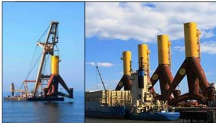
Εικόνα 3.10: Θεμέλιο μορφής τρίποδα (Πηγή: AWS Truwind, LLC, 2009)
