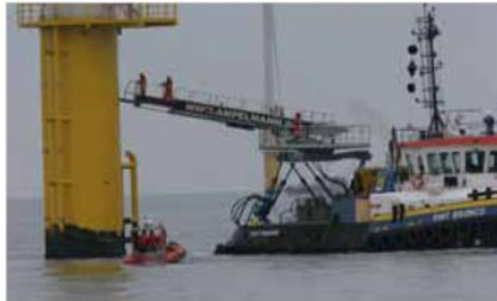
Εικόνα 3.5: Πρόσβαση σε υπεράκτια ανεμογεννήτρια από τη θάλασσα, 1 (Πηγή: EWEA, 2009)
