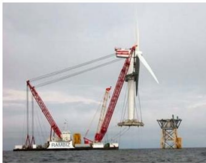
Εικόνα 5.44: Πλοiάριο κατασκευής εγκαθιστά ανεμογεννήτρια πάνω σε θεμελίωση τύπου "jacket" (Πηγή: AWS Truwind, LLC, 2009)
