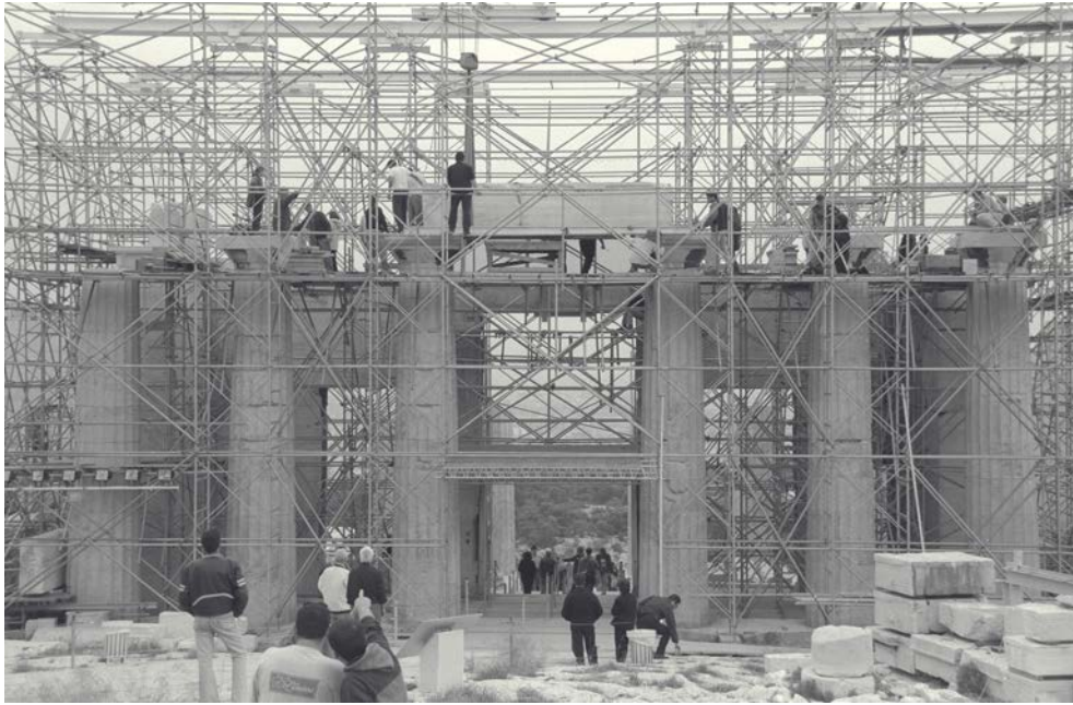
Εικ. 22. Αναστήλωση του επιστυλίου του κεντρικού μετακιονίου της ανατολικής πρόστασης των Προπυλαίων. Πηγή: Φωτ. Αρχείο ΕΣΜΑ.
