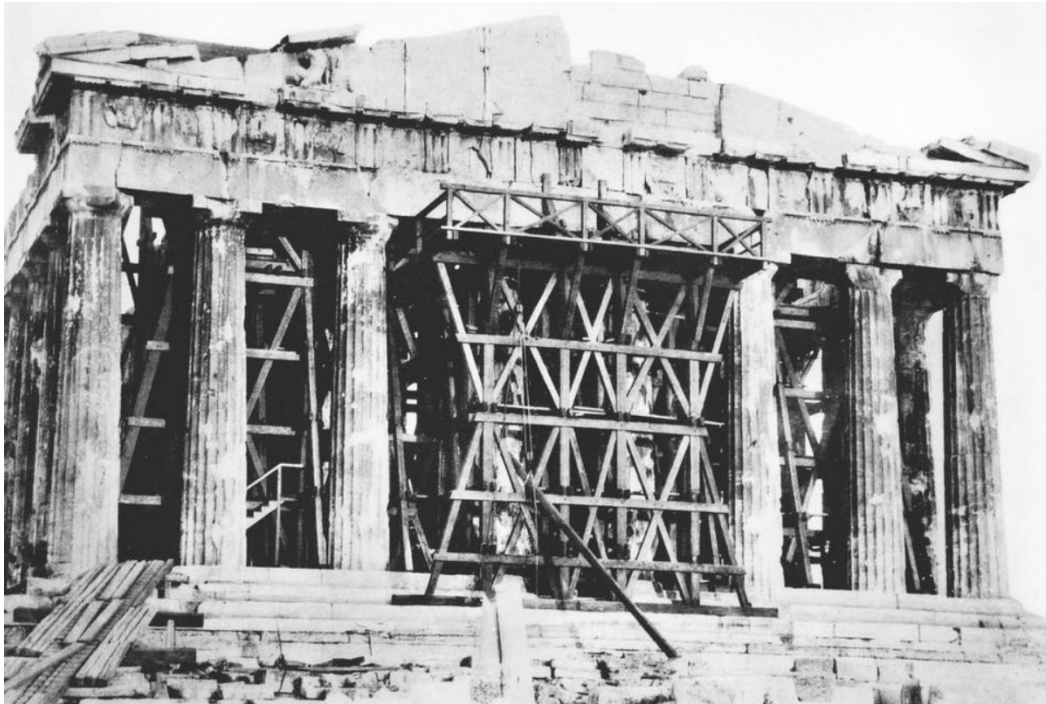
Εικ. 13. Αναστηλωτικές εργασίες υπό τον Μπαλάνο στη δυτική πρόσοψη του Παρθενώνα. Πηγή: ΥΣΜΑ
