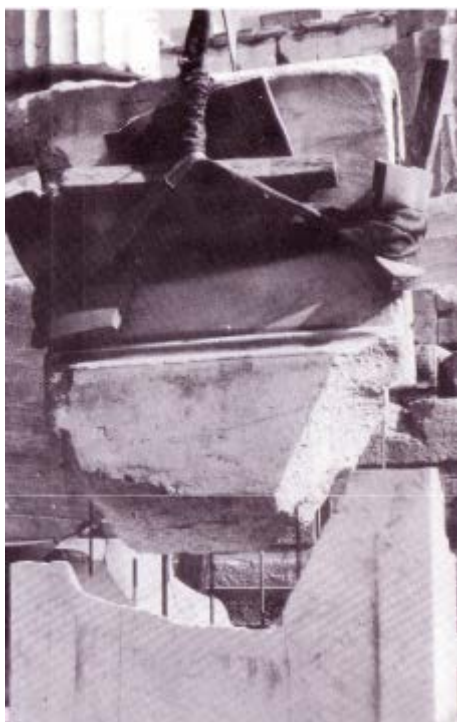
Εικ. 26. Συγκόλληση αυθεντικού τμήματος καταετίου γείσου με συμπλήρωμα νέου μαρμάρου. Πηγή: Πάσιου (2014)
