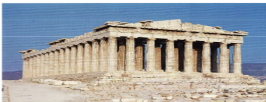
Εικ. 6. Η βορειοδυτική πλευρά του Παρθενώνα. Πηγή: Κορρές, Μ. (2000), φωτ. Μαυρομμάτης, Σ.
