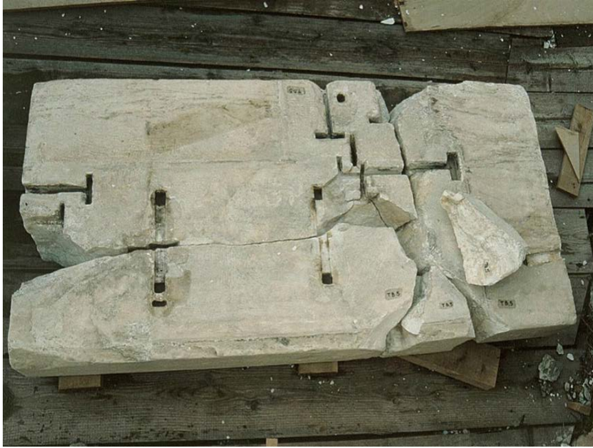
Εικ. 16. Θραύση μέλους λόγω διόγκωσης οξειδωμένων συνδέσμων από προηγούμενες αναστηλωτικές επεμβάσεις. Πηγή: ΥΣΜΑ
