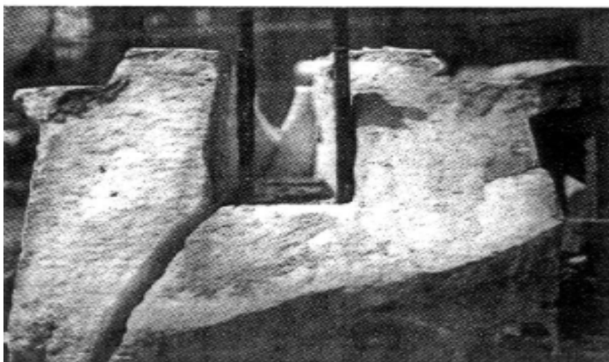
Εικ. 23. Διάρρηξη μαρμάρου λόγω οξείδωσης στοιχείων ανάρτησης δοκού. Πηγή: Tanoulas, T., Ioannidou, M., Moraitou, A. (1994)
