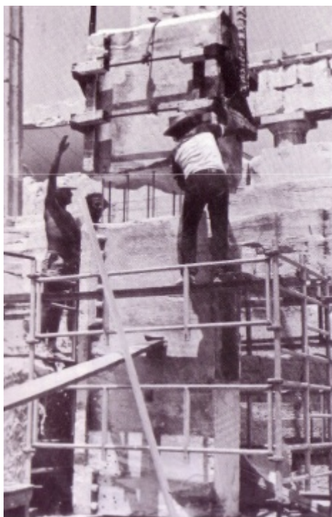
Εικ. 25. Συγκόλληση δύο τμημάτων του εξωτερικού επιστηλίου Β. γωνίας Α. πλευράς Παρθενώνα με οπλισμό τιτανίου. Πηγή: Πάσιου (2014)
