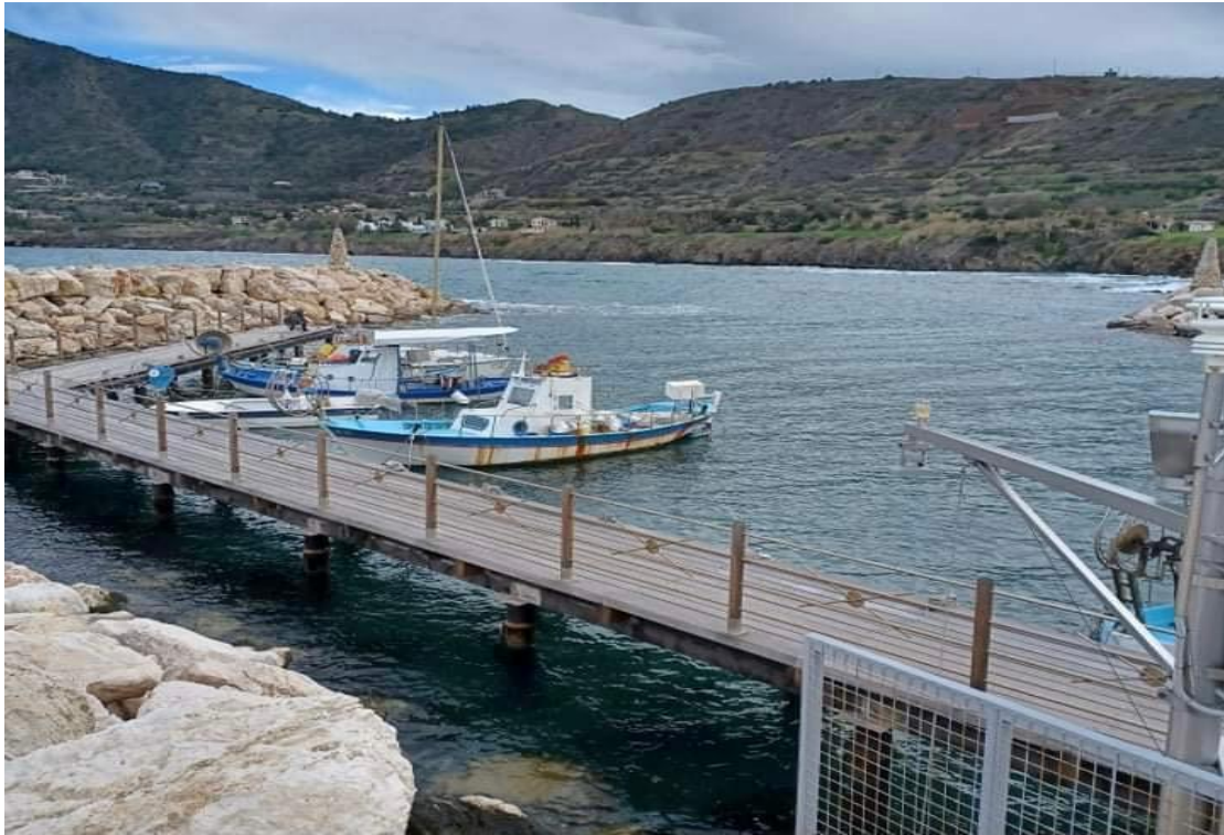
Εικόνα 5-38: Υφιστάμενη κατάσταση αλιευτικού καταφυγίου Πωμού (Πηγή: Προσωπικό αρχείο).
