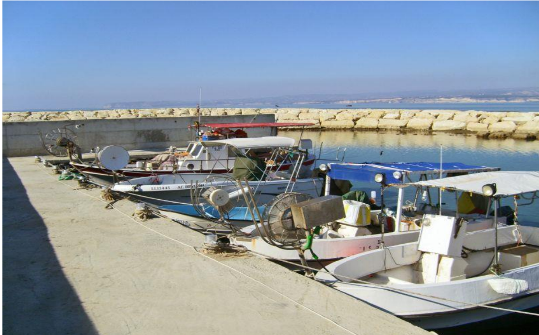
Εικόνα 5-29: Υφιστάμενη κατάσταση αλιευτικού καταφυγίου Ακρωτηρίου (Πηγή: Προσωπικό αρχείο).
