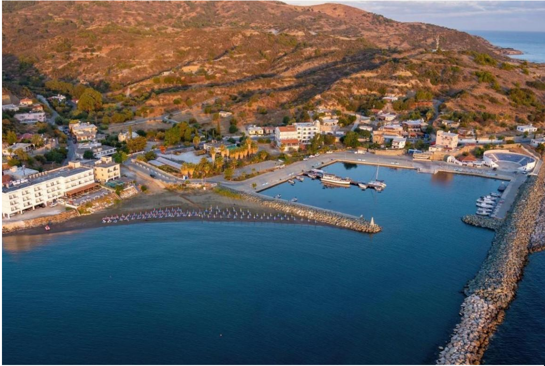
Εικόνα 5-39: Αλιευτικό καταφύγιο Κάτω Πύργου (Πηγή: katorpyrgos.cy ).
