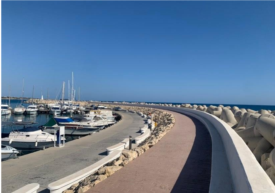
Εικόνα 5-25: Τεχνητοί ογκόλιθοι στο αλιευτικό καταφύγιο Ζυγίου (Πηγή: Προσωπικό αρχείο).
