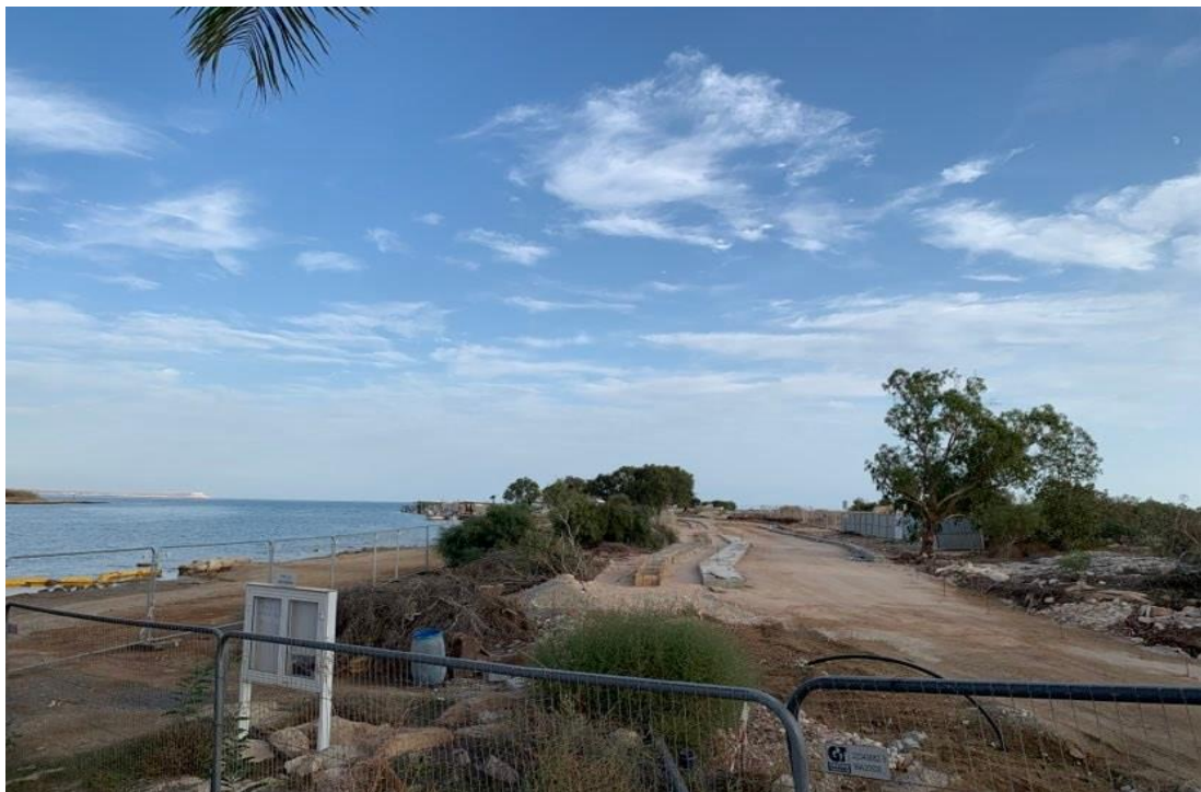
Εικόνα 5-12: Ανακατασκευή αλιευτικού καταφυγίου Λιοπετρίου (Πηγή: Προσωπικό αρχείο).
