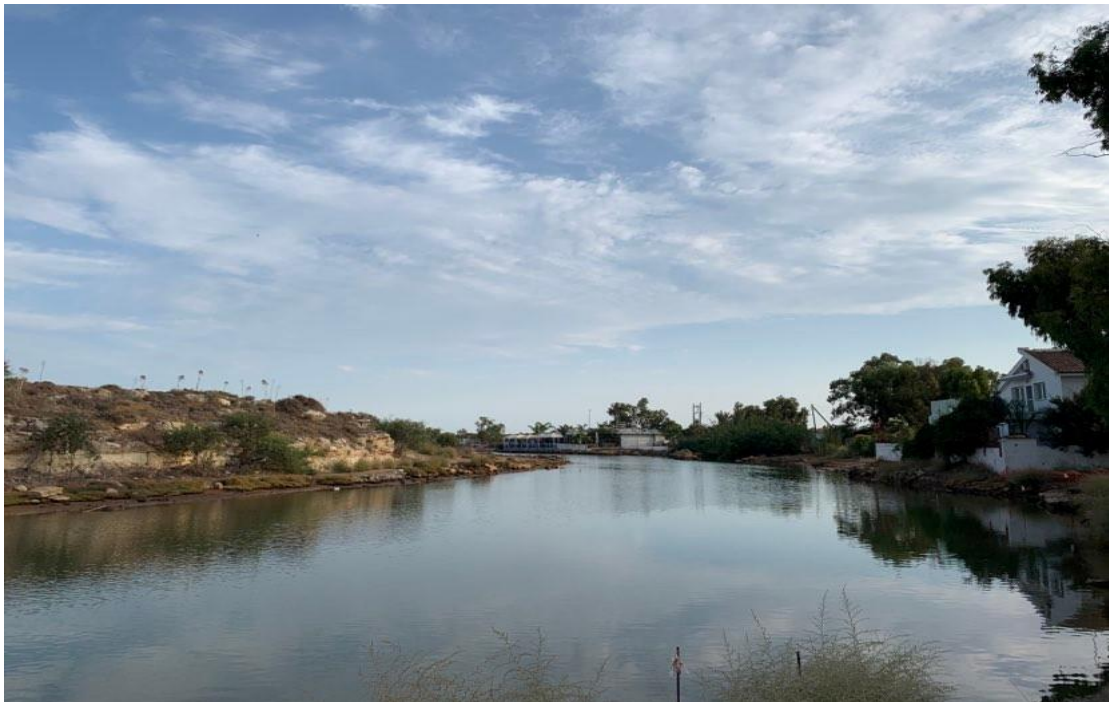
Εικόνα 5-9: Υφιστάμενη κατάσταση αλιευτικού καταφυγίου Λιοπετρίου (Πηγή: Προσωπικό αρχείο).
