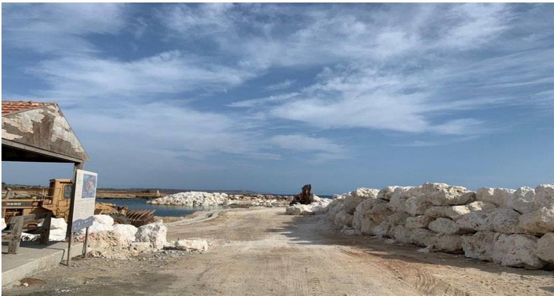
Εικόνα 5-18: Υπερύψωση του κυματοθράυστη (Πηγή: Προσωπικό αρχείο).
