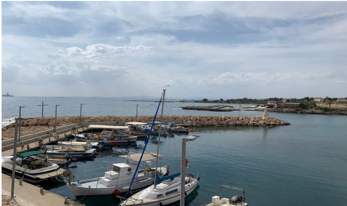
Εικόνα 5-19: Υφιστάμενη κατάσταση του αλιευτικού καταφυγίου Ξυλοτύμπου (Πηγή: Προσωπικό αρχείο).
