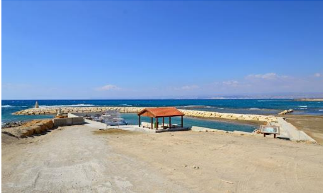
Εικόνα 5-28: Αλιευτικό καταφύγιο Ακρωτηρίου (Πηγή: allaboutlimassol.com ).
