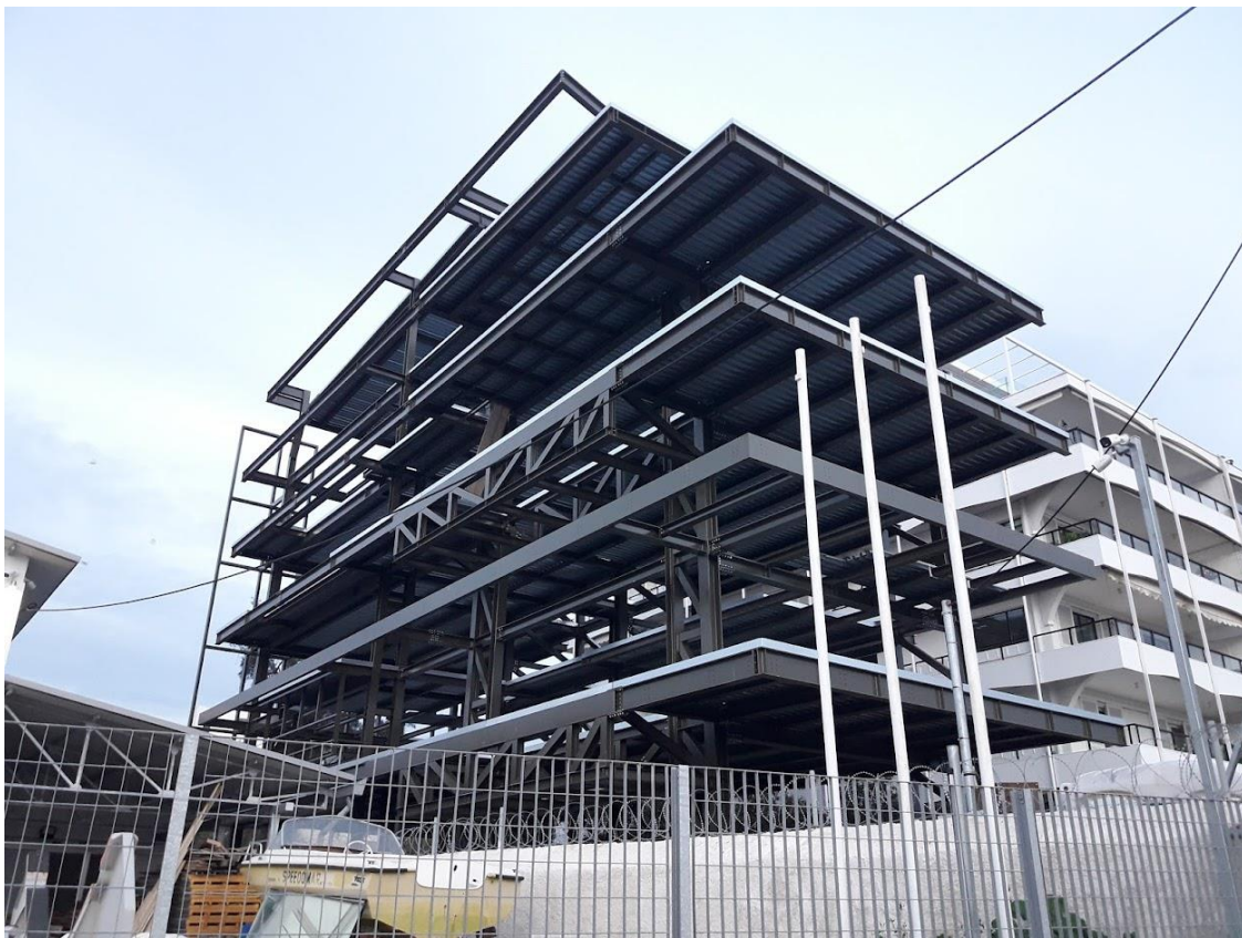
Εικόνα 10: Πολυκατοικία από μεταλλικό σκελετό στη Γλυφάδα Αττικής | 2020
