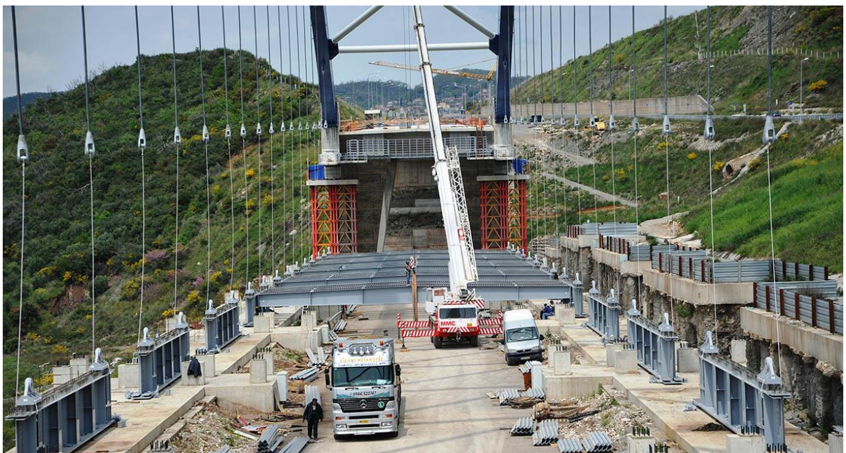
Εικόνα 8: Γέφυρα Τσακώνας | Κατάστρωμα | 2016
