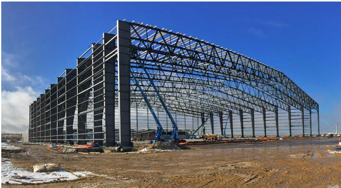
Εικόνα 6: Βιομηχανικό Κτίριο μεγάλου ανοίγματος στην Ευρώπη
