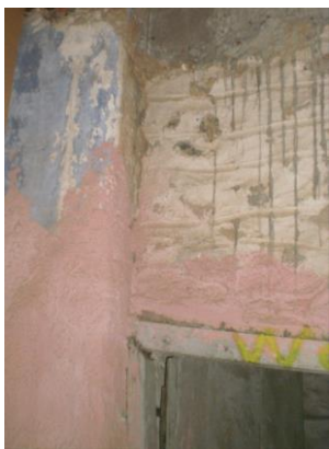
Εικόνα Β30 Αρμός μεταξύ Α' και Β' πτέρυγας
