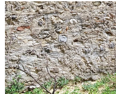
Εικόνα Β64 Όψη εξωτερικής στρώσης τοιχοποιίας στην θέση της διερευνητικής τομής Ι
