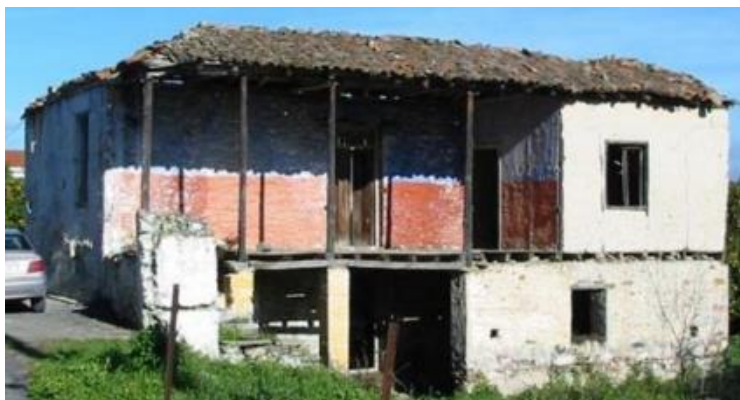
Εικόνα Α21 Μακρινάρι με προσθήκη σε διάταξη Γ (πηγή: Γ. Γιαξόγλου)
