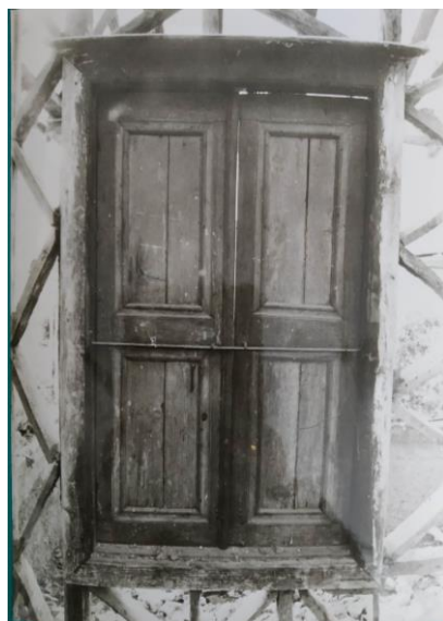
Εικόνα Β41 Κούφωμα του τσατμαδότοιχου και λεπτομέρειες (πηγή: αρχείο ΕΦΑΛΑΚ)
