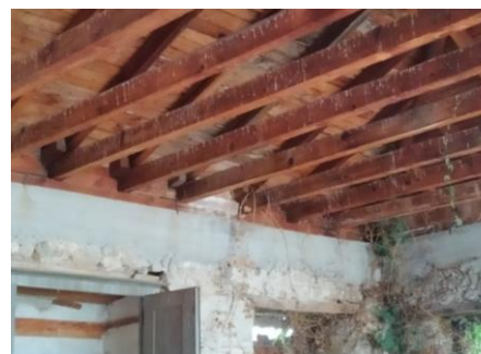
Εικόνα Β79 Το διάζωμα και η στέγη της πτ. Β΄
