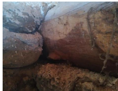
Εικόνα B83 Στήριξη δοκού της πτ. Α' σε δοκοθήκη
