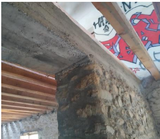
Εικόνα Β68 Διάζωμα ω.σ. στην στάθμη του πατώματος της πτερ. Α'
