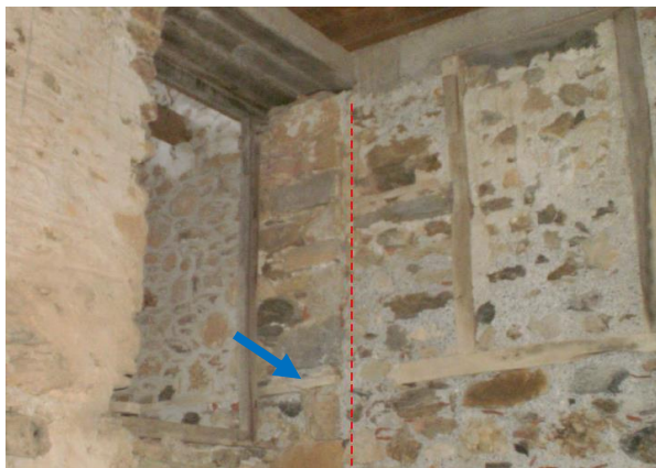
Εικόνα B25 Αρμός μεταξύ πτέρυγας Β' και Α'
