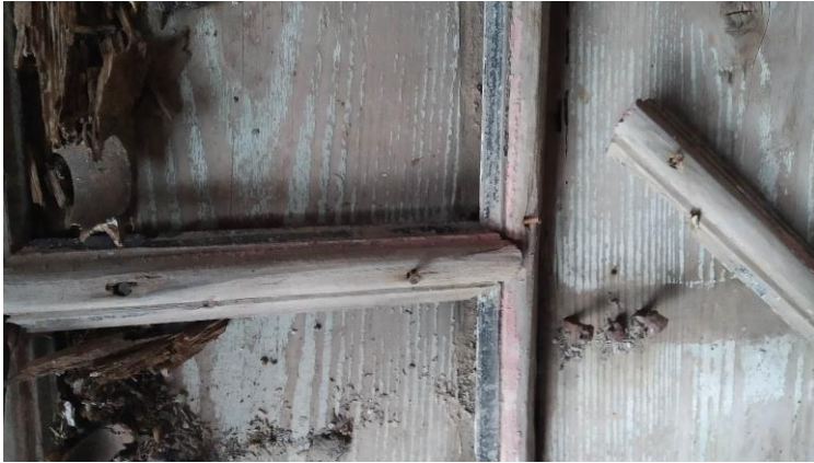
Εικόνα Β58 Τμήμα της παλαιάς ψευδοροφής της πτέρυγας Α΄
