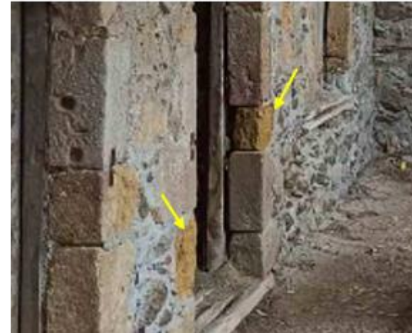
Εικόνα Γ9 Λίθοι χαμηλής αντοχής διάσπαρτοι στην τοιχοποιία
