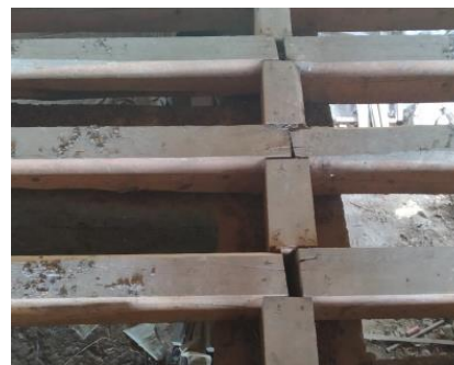
Εικόνα B82 Έδραση των δοκών της πτ. Α' στο διάζωμα
