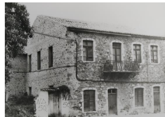
Εικόνα B24 Η ΝΔ όψη το 1978 (πηγή: αρχείο ΕΦΑΛΛΑΚ)
