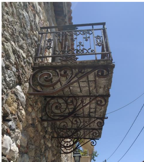
Εικόνα Β88 Αποκάλυψη οπλισμού στο κάτω μέρος της πλάκας
