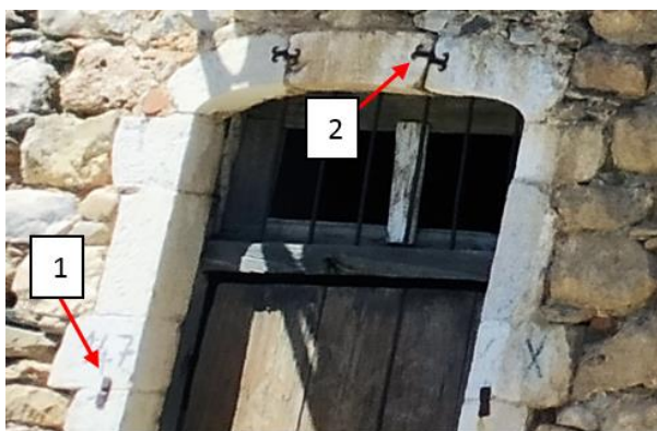
Εικόνα Β15 Τζινέτια τύπων 1 & 2, κούφωμα και λαξευτές παραστάδες ΝΔ όψης
