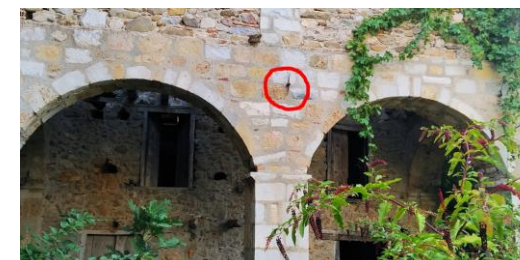
Εικόνα B51 Κλειδί αγκύρωσης στην ΝΑ όψη της τοξοστοιχίας
