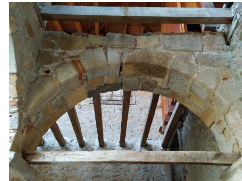
Εικόνα Β34 Ο μοναδικός ελκυστήρας της τοξοστοιχίας
