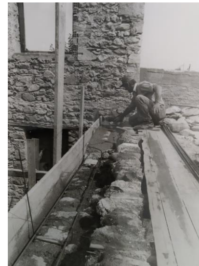
Εικόνα Β78 Εργασίες στην πτέρυγα Β' το 1981 (πηγή: ΕΦΑΛΑΚ)
