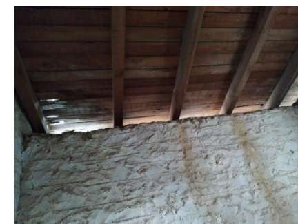
Εικόνα Β80 Η στέγη της πτέρυγας Γ΄
