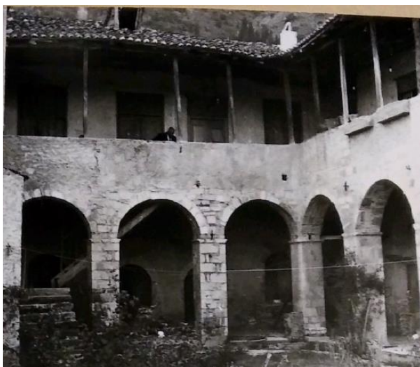
Εικόνα Β54 Η ΒΑ όψη με τις ζαρντινιέρες από σκυρόδεμα το 1978 (πηγή: αρχείο ΕΦΑΛΑΚ)
