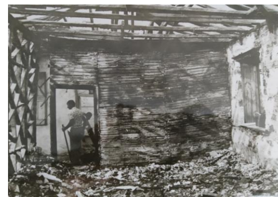
Εικόνα B38 Η πτέρυγα Β' και μαγδατότοιχος του μαγειρείου το 1981 (πηγή: αρχείο ΕΦΑΛΑΚ)
