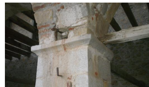
Εικόνα B66 Θέση συμβολής τόξων
