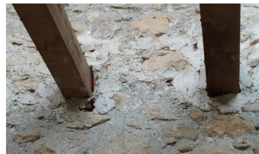
Εικόνα B84 Στήριξη δοκών του χαγιατιού σε δοκοθήκες
