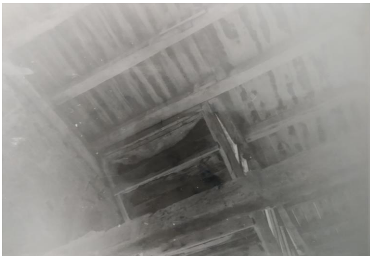
Εικόνα Β42 Απόληξη κλίμακας στο χαγιάτι (πηγή: αρχείο ΕΦΑΛΑΚ)
