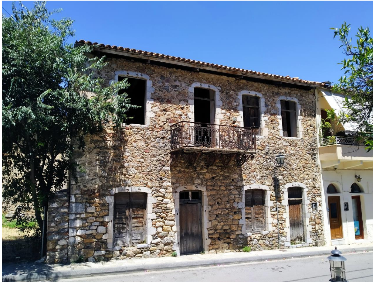
Εικόνα Β1 Η νοτιοδυτική όψη (Ιουν. '21)
