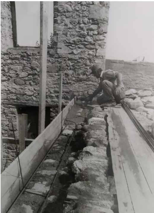
Εικόνα Β60 Οι εργασίες του 1981 εν εξελίξει (πηγή: αρχείο ΕΦΑΛΑΚ)
