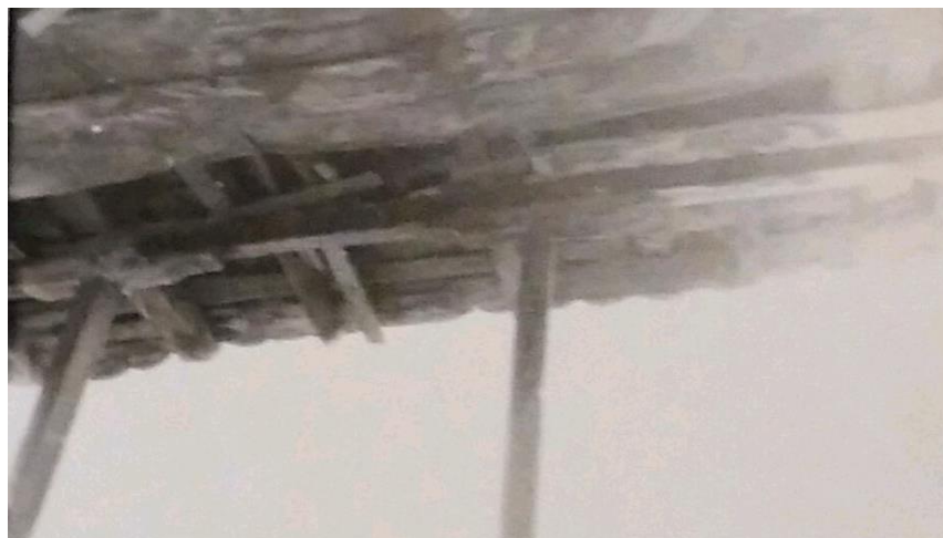
Εικόνα Β43 Ξύλινο γέισο στο χαγιάτι (πηγή: αρχείο ΕΦΑΛΑΚ)
