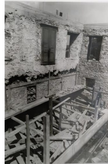
Εικόνα Β77 Εργασίες στην πτέρυγα Β' το 1981 (πηγή: ΕΦΑΛΑΚ)
