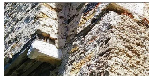
Εικόνα B50 Ξυλοδεσιά ανάμεσα στους γωνιόλιθους της πτ. Β'
