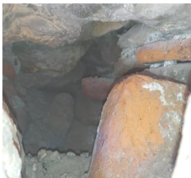
Εικόνα Β63 Το εσωτερικό της τοιχοποιίας από σκαλότρυπα της ΝΔ όψης
