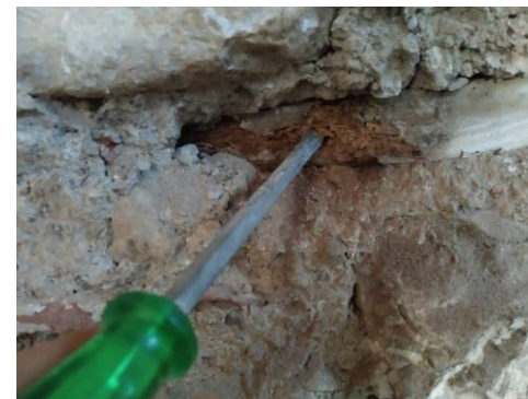
Εικόνα B65 Μη εμφανής ξυλοδεσιά σε σήψη
