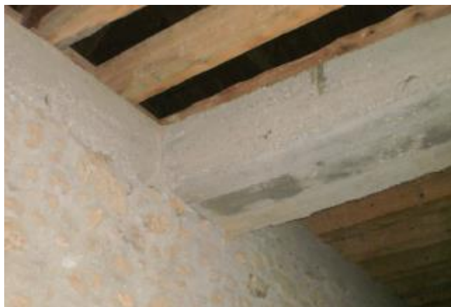
Εικόνα Β69 Διάζωμα ω.σ. στην στάθμη του πατώματος της πτερ. Α'
