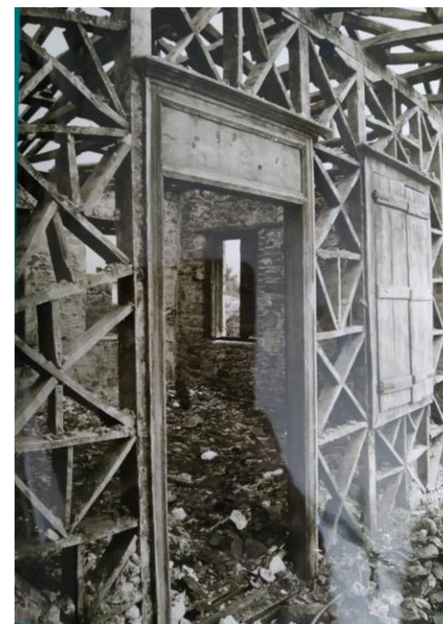
Εικόνα B37 Ο τσατμαδότοιχος μετά την αποδόμησή του το 1981 (πηγή: αρχείο ΕΦΑΛΑΚ)
