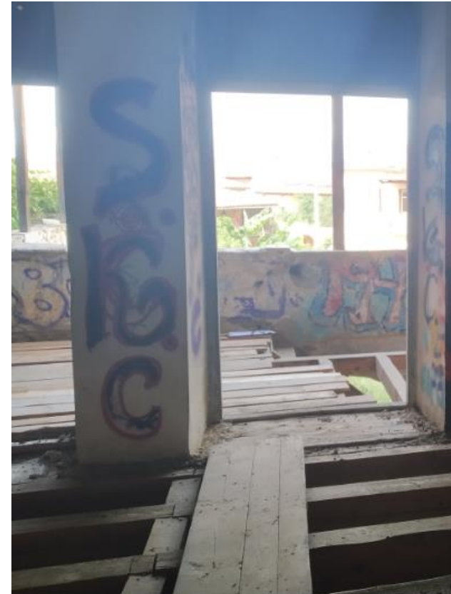
Εικόνα Β62 Ξύλινες σανίδες που χρησιμοποιήθηκαν για την προσέγγιση στον άνω όροφο
