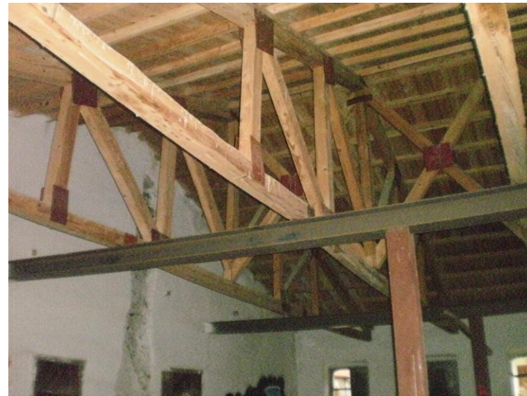
Εικόνα Β61 Γενική άποψη της στέγης του 1991
