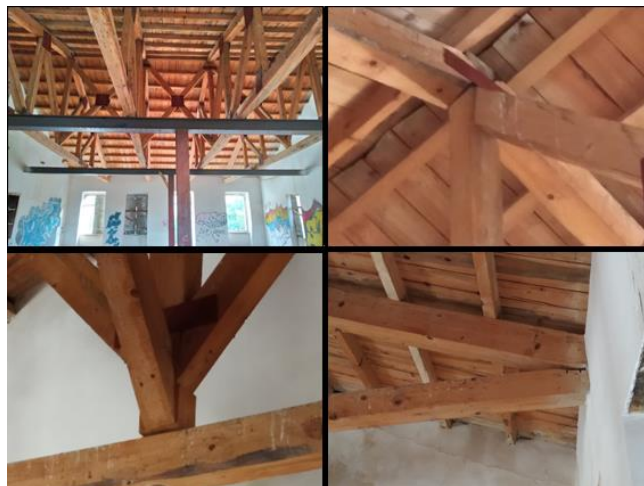
Εικόνα Β85 Γενική άποψη και ξυλουργικές συνδέσεις στέγης Α΄
