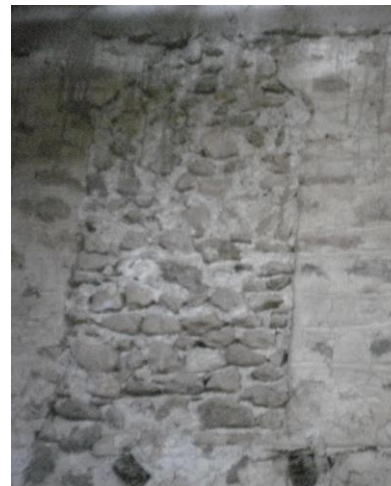
Εικόνα B29 "Κλεισμένο" τζάκι στο μεσοπάτωμα
