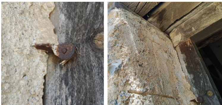
Εικόνα Β19 Νέο τζινέτι και ξύλινο υπέρθυρο
