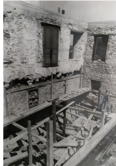
Εικόνα Β56 Οι εργασίες του 1981 εν εξελίξει (πηγή: αρχείο ΕΦΑΛΛΑΚ)
