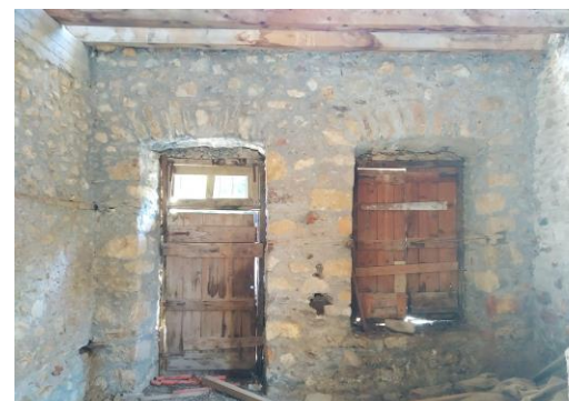
Εικόνα B16 Χθαμαλά τοξωτά υπέρθυρα της ΝΔ όψης από το εσωτερικό
