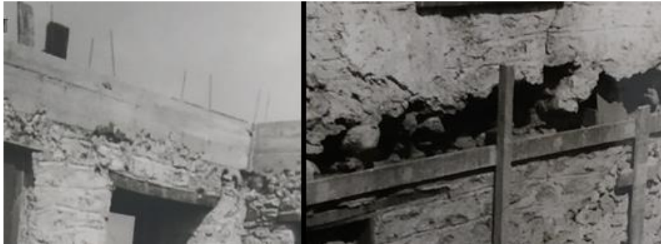
Εικόνα Β75 Κατασκευή διαζωμάτων στέγης το 1981 (πηγή: ΕΦΑΛΑΚ)
