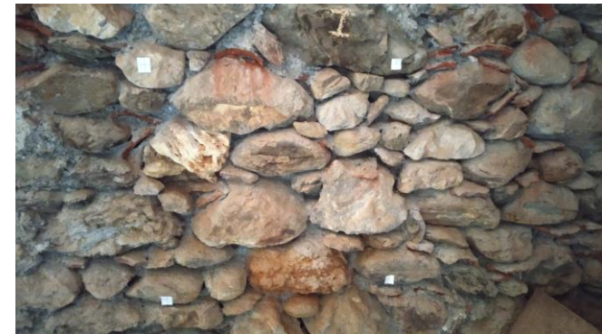
Εικόνα Γ10 Όψη τοιχοποιίας πριν την διερευνητική τομή I
