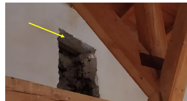
Εικόνα B72 Κεκλιμμένο διάζωμα από ω.σ. στη στέγη της πτ. Α΄
