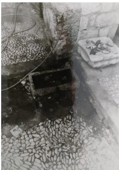
Εικόνα Β45 Τμήμα του βοτσαλωτού δαπέδου του χαγιατιού, μαρμάρινη γούρνα και srolium (πηγή: αρχείο ΕΦΑΛΑΚ)
