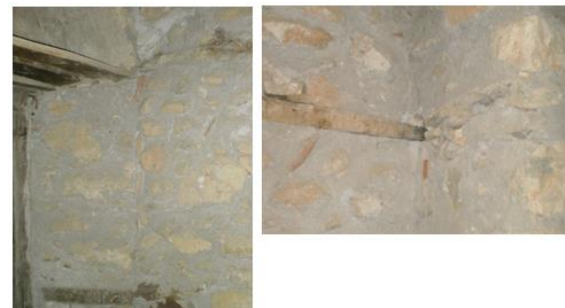
Εικόνα B49 Σύνδεση διαχωριστικού τοίχου με τις όψεις
