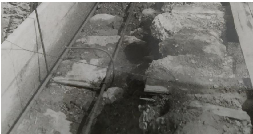
Εικόνα Β76 Κατασκευή διαζώματος στην στάθμη του πατώματος 1981 (πηγή: ΕΦΑΛΑΚ)
