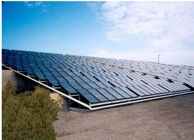
Εικόνα 3.5: Επιλεκτικοί ηλιακοί συλλέκτες 2.664m^2 για κλιματισμό στα Οινόφυτα [18]
