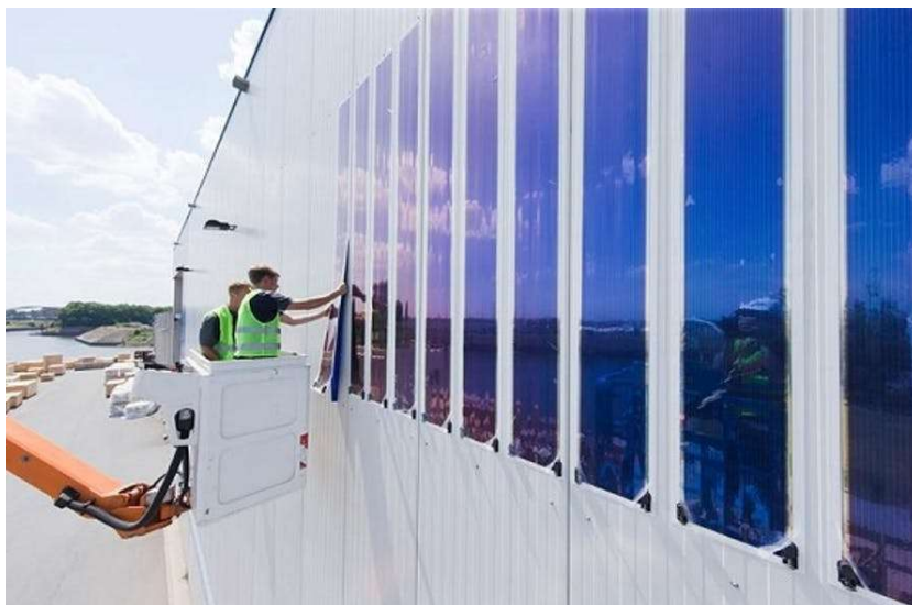
Εικόνα 8.4: Τοποθέτηση οργανικών φωτοβολταϊκών σε αποθήκη σε λιμάνι στην Γερμανία [73]
