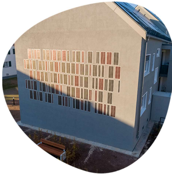
Εικόνα 8.8: Οργανικά φωτοβολταϊκά σε ενσωματωμένα σε τοίχο κτιρίου [72]
