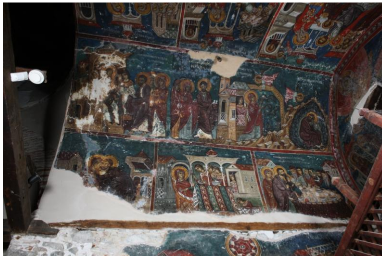
Εικόνα 5.3: Η εικόνα περιγράφει τμήμα της τομής, ακολουθεί η ορθοφωτογραφία που προέκυψε από αυτή την εικόνα.
