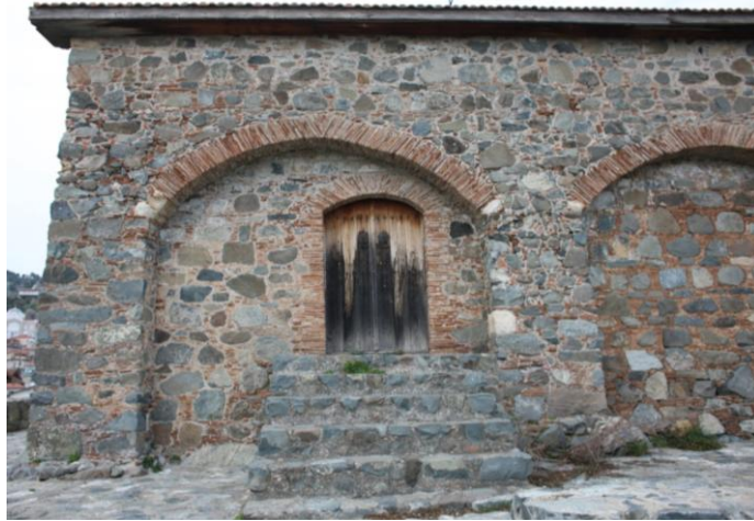
Εικόνα 5.6: Νότια όψη της εκκλησίας. Η λήψη φαίνεται ότι δεν είναι παράλληλη με το αντικείμενο αλλά έχει μια μικρή κλίση ( \omega = -103, 103^\circ αντί για -90^\circ ).
