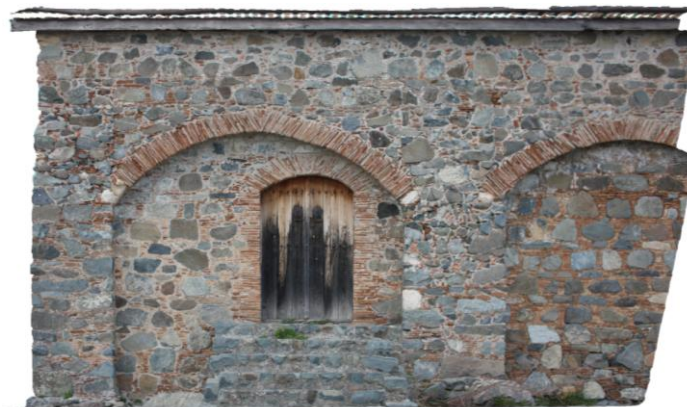
Εικόνα 5.7: Ορθοφωτογραφία της 5.6 μετά το γεωμετρικό μετασχηματισμό της κεντρικής προβολής σε ορθή, η όψη απεικονίζεται στη σωστή οριζοντιογραφική της θέση απαλλαγμένη από τις παραμορφώσεις της κλίσης της φωτογραφικής μηχανής.
