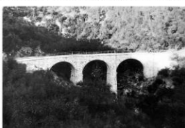
Αίθρου τριφυλές γέφυρα άνοιγμα 30μ. | γέφυρα από πέτρα Μισσοροβί | ελαστικότητα με γέφυρα πλάσι από τρία μικρά σχήματα από το μηχανικό Ματζίλι
