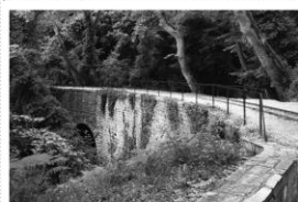
Αίθρου μονόφυλλη γέφυρα άνοιγμα 40μ. | γέφυρα "του σταθμού" | μπροστά καταρράκτης ανάμεσα στους βράχους
