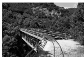
μεταλλική γέφυρα με εύθλιμους φορείς πάνω στον οποίο η γραμμή διαγράφει καρπώδη τριφυλές | μήκος 36μ. | πάνω από βράχιο 40μ. | γεφύρα από σιδηροβότα Μπελερινίου γέφυρα "Παύλου" από το αρχαιότερο εκκλησάκι πάνω στο βράχο ή γέφυρα "της Αγίας" από το μηχανικό που κλείνει ένα το ελαστικό άνοιγμα | σχεδιασμένη από το μηχανικό Schneider | πάνω ελαστικό μεταλλικό ζυγό με τριφυλές "ένα διαδρομή" χωρίς ενδιάμεση αποβάθρα, παρατηρείται ως έργο αντιστάσεως του Πύργου του Σαφά
