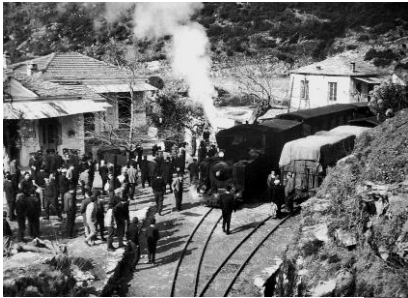
σταθμός Άνω Γατζέας
