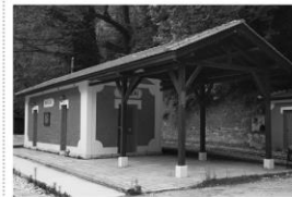
από μονόροφο και λατινικού Αίθρου κτίριο με ξύλινο υπόστρεγο και ξύλινη στέγη | ανακατασκευής με προσωνύμιο κτίριο με προσωνύμιο ανακατασκευής μετά την επέκταση προς Ζαχάρη, η οποία δεν πραγματοποιήθηκε ποτέ | ανακατασκευής το 1996 μετά από τους σεισμούς των 1984-5 - σαναός από καθύστες | υποστηρίγματα υδατοπέλας | αναπλήρωση οριζώντων συντηρήσεις | πλαστική, τουαλέτες, φουάρες | ξύλινο υπόστρεγο μηχανοστασίου | πυρασφαγή πλακά | τρένο |
