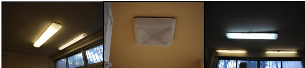
Εικόνα 4.6. Φωτιστικά σώματα με γαλακτερούς διαχύτες.
