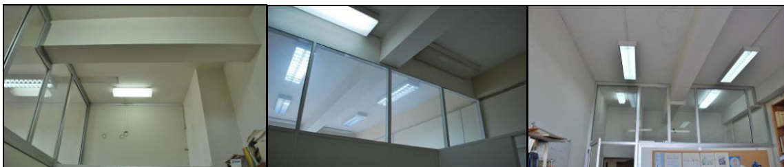
Εικόνα 4.10. Παραδείγματα χώρων που δημιουργήθηκαν μετά την προσθήκη χωρισμάτων, στους οποίους οι διακόπτες που ελέγχουν τα φωτιστικά τους βρίσκονται σε άλλο χώρο.
