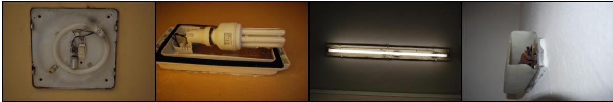
Εικόνα 4.8. Παραδείγματα φωτιστικών με σπασμένο διαχύτη.
