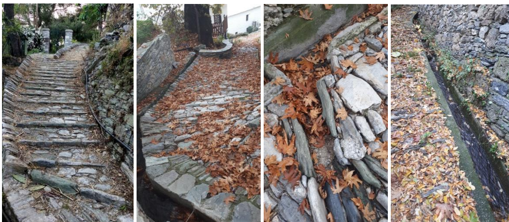
Εικόνα 41. Σύνθεση εικόνων που απεικονίζουν τον τρόπο κατασκευής των χαρακτηριστικών καλντεριμιών του χωριού.
