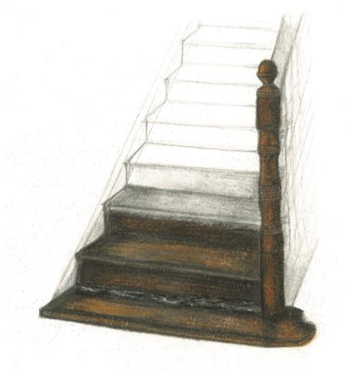
Εικόνα 71. Λεπτομέρεια της απόληξης της ξύλινης σκάλας, όπου παρουσιάζεται η φθορά στην επένδυση των ξύλινων σανιδιών.
