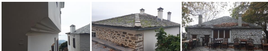
Εικόνα 30. Σύνθεση φωτογραφιών που απεικονίζουν την χρήση του ασβεστοκονιάματος της σύγχρονες κατοικίες του χωριού.
