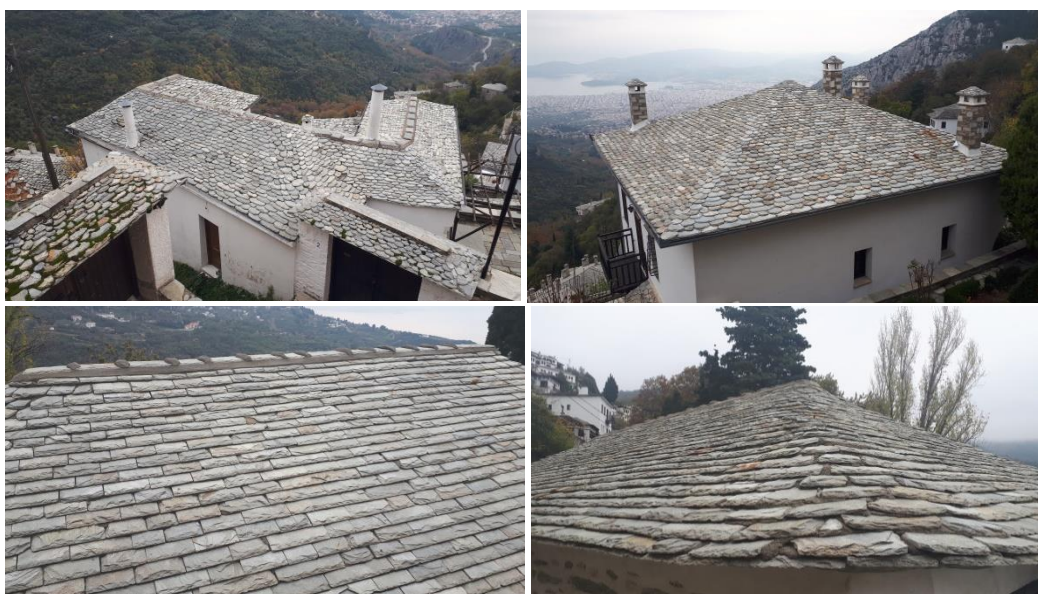
Εικόνα 29. Σύνθεση εικόνων που απεικονίζουν τον τρόπο κατασκευής των τοπικών σκεπών από σχιστόπλακα.
