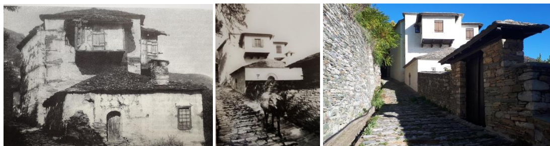
Εικόνα 23. Ο πύργος της σημερινής ιδιοκτησίας Κωνσταντινίδη πριν την επισκευή του (αριστερά), μετά την επισκευή του (κέντρο) και κατά την σημερινή του κατάσταση (δεξιά).
