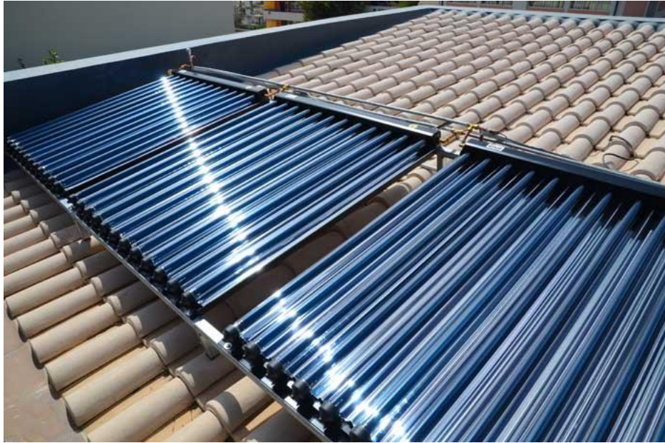
Εικόνα 1. Ο ETC συλλέκτης εμπορίου στον οποίο βασιστήκαμε κατασκευαστικά.
