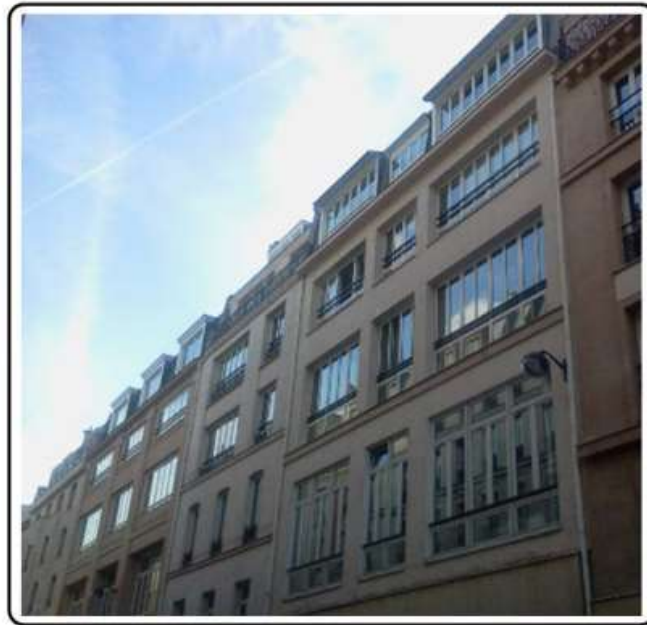
Σχήμα 2.11 Ο διαστάσεις των οπών περιορίζονται με την αύξηση της απόστασης τους από το έδαφος (μεγαλύτερη παροχή φυσικού φωτισμού). - <<πηγή: Α. Τσαγκρασούλης, 2016>>
