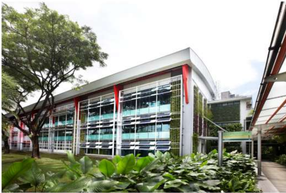
Σχήμα 2.52 Φωτοβολταϊκή συσκευή με σκιασμό σε κτίριο μηδενικής κατανάλωσης ενέργειας στην Σιγκαπούρη. <<Πηγή Pacheco et al, 2013>>
