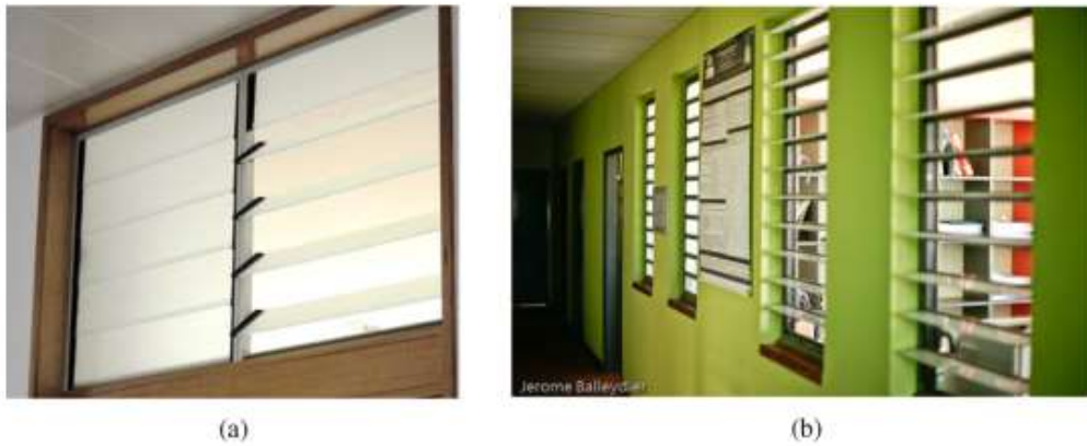
Σχήμα 2.5 Φυσικός διαμπερής αερισμός μέσω εσωτερικών περσίδων- ανοιγμάτων. <<πηγή: Α. Τσαγκρασούλης, 2016>>
