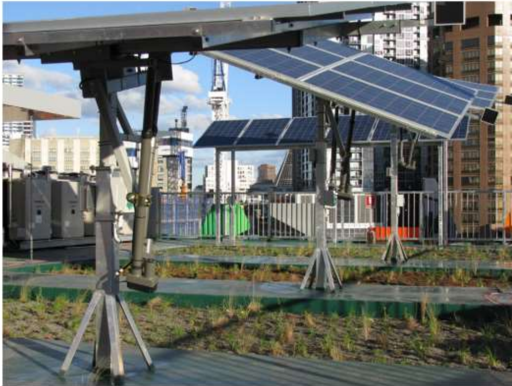
Σχήμα 2.49 Σύστημα παρακολούθησης ηλιακής γωνίας σε δώμα κτιρίου στην Αυστραλία. <<Πηγή Pacheco et al, 2013>>
