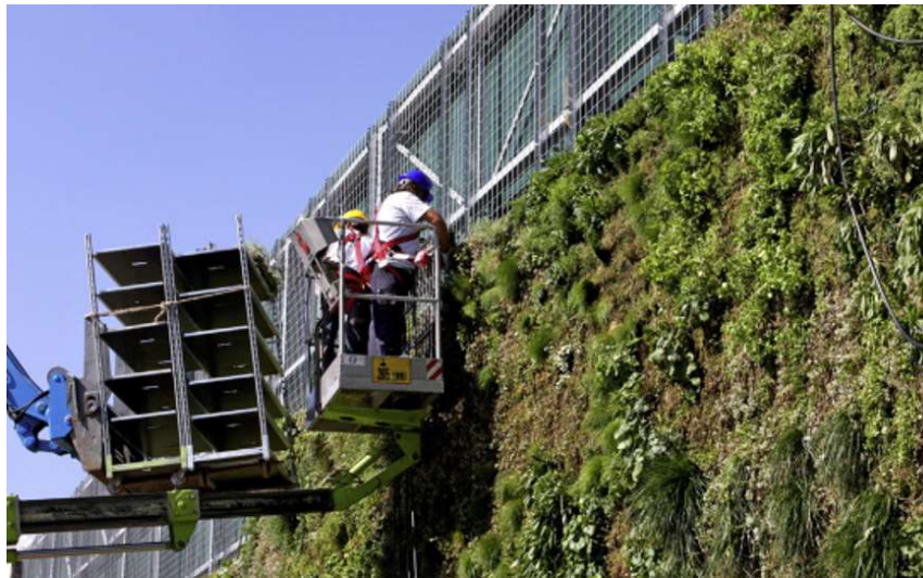
Σχήμα 2.37 Εγκατάσταση στοιχείων πράσινου τοίχου. <<Πηγή: Casini, 2016>>
