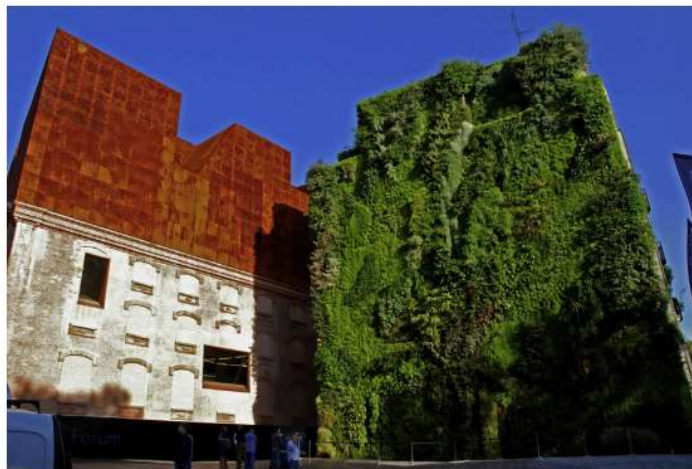
Σχήμα2.42 Caixa Forum, Herzog & de Meuron/Patrik Blanc, Μανδρίτη. <<Πηγή: Casini, 2016>>
