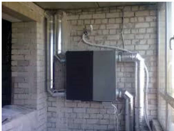
Σχήμα 5.12 Τυπική θέση τοποθέτησης εναλλάκτη θερμότητας. <<Πηγή: Casini, 2016>>
