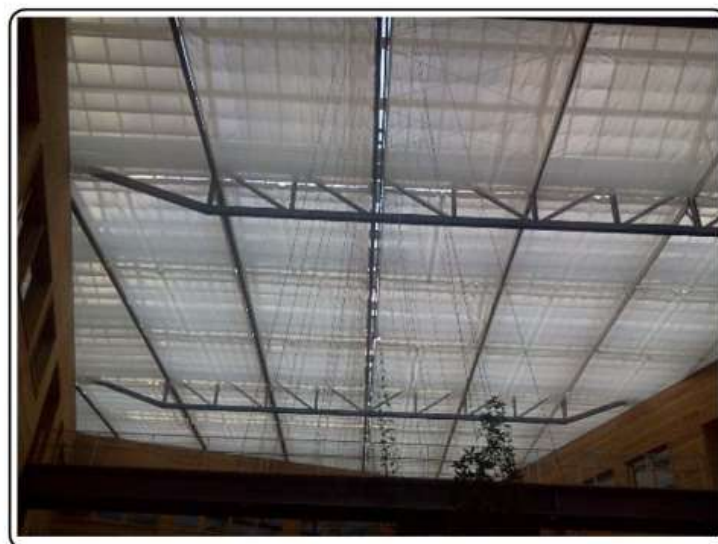
Σχήμα 2.26 Χρήση εσωτερικής σκίασης αιθρίου. <<πηγή: Α. Τσαγκρασούλης, 2016>>
