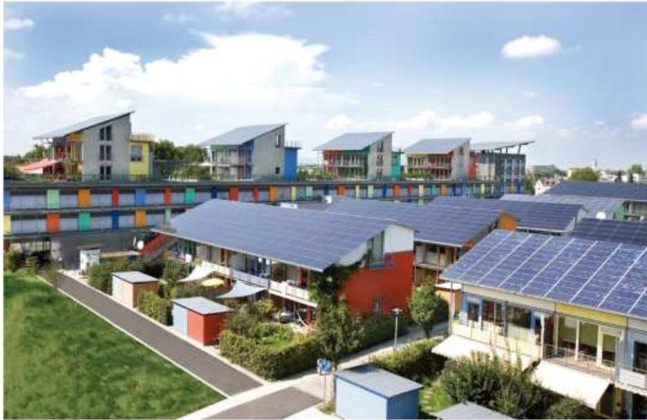
Σχήμα 2.50 Πλήρως ενσωματωμένη BIPVσε οροφές PlusEnergy συνοικίας, Freiburg, Γερμανία. <<Πηγή Pacheco et al, 2013>>
