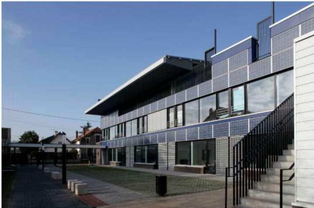
Σχήμα 2.51 Πλήρως ενσωματωμένο σε τοίχο σύστημα BIPVσε σχολείο στο Limeil-Brevannes, Γαλλία. <<Πηγή Pacheco et al, 2013>>
