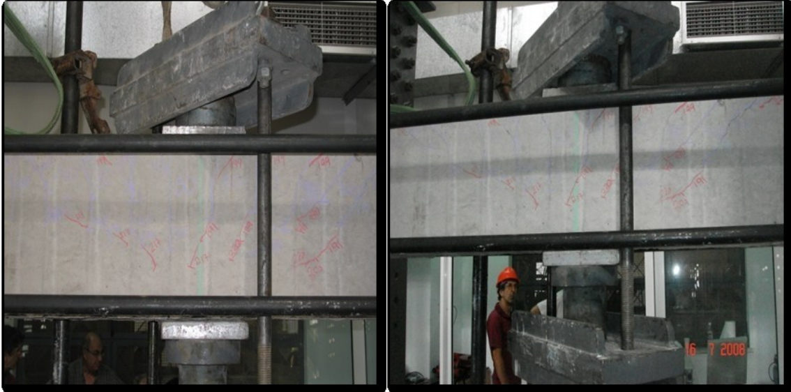
ΕΙΚΟΝΑ 4.9 Ρηγμάτωση του φορέα στην θέση επιβολής του εγκάρσιου φορτίου.
