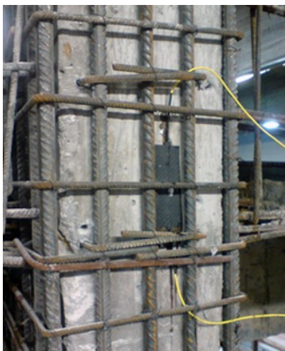
Εικόνα 17. Εγκατάσταση αισθητήρα μέτρησης αξονικής παραμόρφωσης σε υποστώμα κτιρίου
