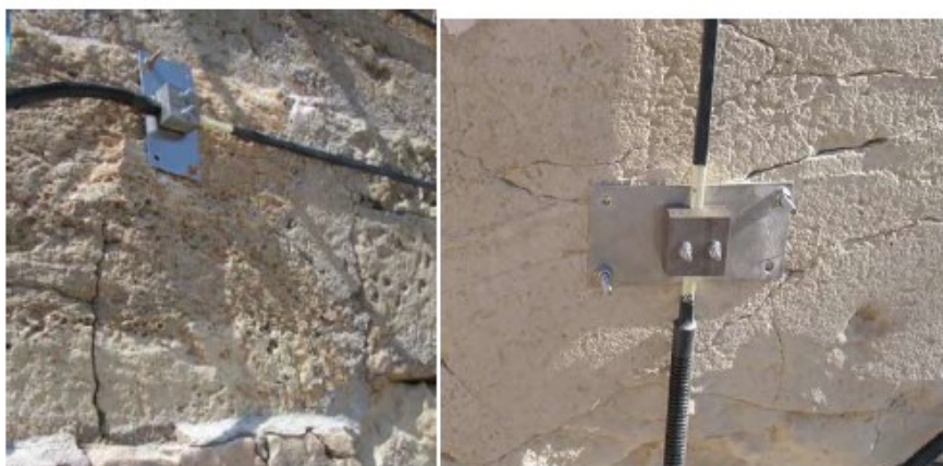
Εικόνα 47. (α) & (β) Αγκύρωση αισθητήρα παραμόρφωσης
