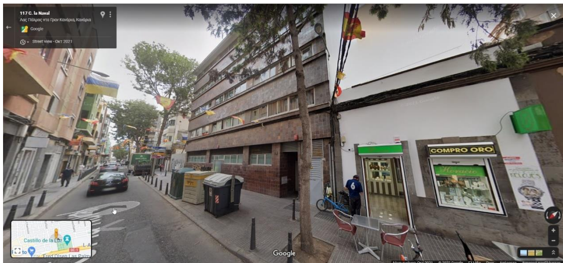
Εικόνα 3.16: Παράδειγμα τμήματος με καλή κατάσταση κτιρίων όπου η S_6=1 , στην πόλη Λας Πάλμας (Πηγή: Google Street View)
