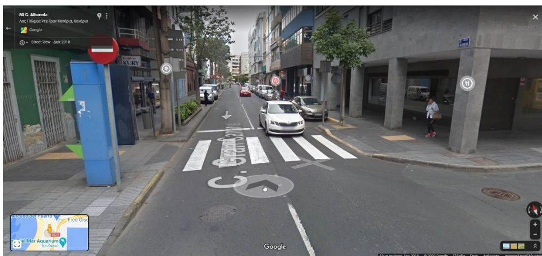
Εικόνα 3.51: Παράδειγμα σύνδεσης πεζοδρομίων με διάβαση πεζών όπου η C1\_3=1 στην πόλη Λας Πάλμας (Πηγή: Google Street View)
