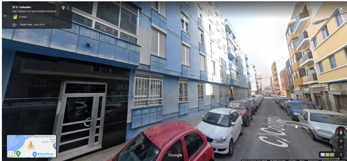
Εικόνα 3.2: Παράδειγμα χρήσης γης όπου S1=0 , στην πόλη Λας Πάλμας (Πηγή: Google Street View)
