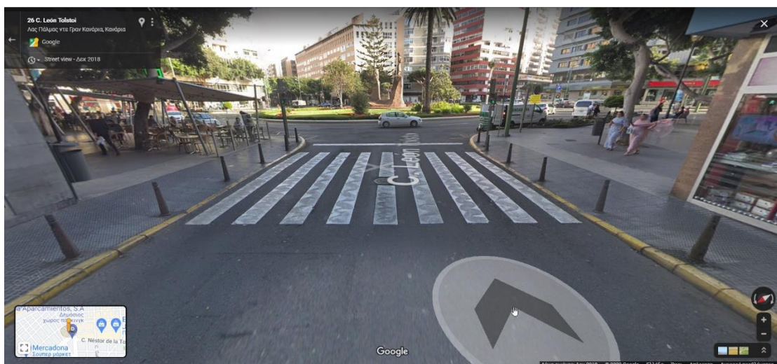
Εικόνα 3.54: Παράδειγμα σύνδεσης πεζοδρομίων με ράμπες σε καλή κατάσταση όπου η C1_4=2 στην πόλη Λας Πάλμας (Πηγή: Google Street View)
