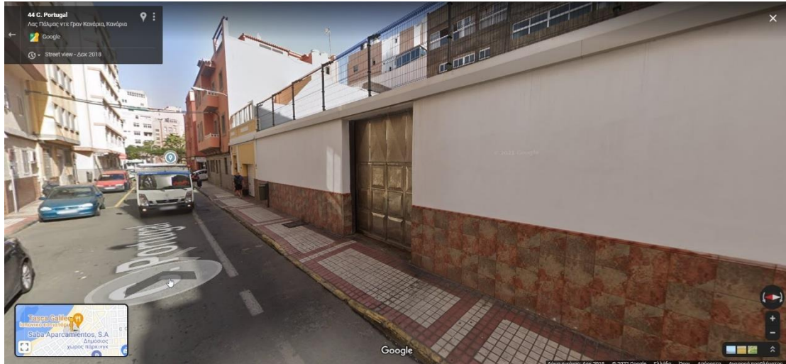
Εικόνα 3.28: Παράδειγμα τμήματος πεζοδρομίου χωρίς διαχωρισμό από την κυκλοφορία όπου η S11=0 , στην πόλη Λας Πάλμας (Πηγή: Google Street View)
