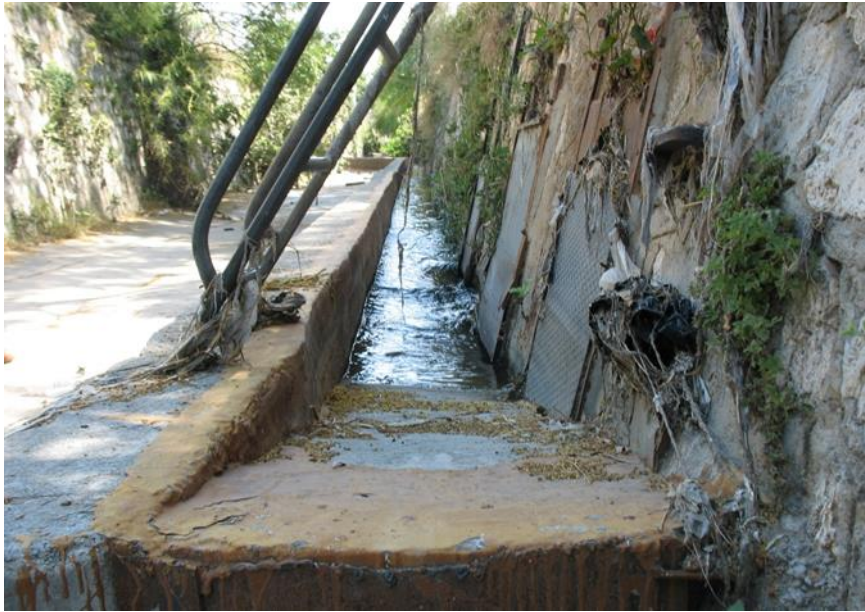
Εικόνα 0-4: Φωτογραφία του έργου εκτροπής E1 εντός της κοίτης του ρέματος Προφήτη Δανιήλ, στο ύψος της οδού Λεγάκη (Κατερίνα Βαγενά, 2019)
