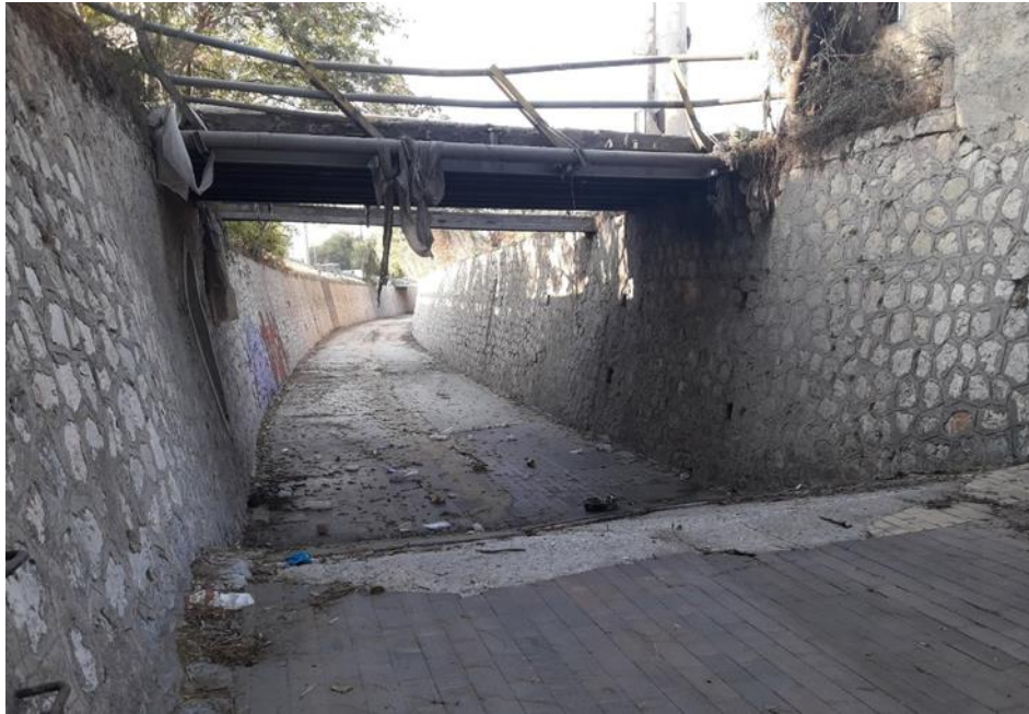
Εικόνα 0-3: Φωτογραφία της λιθεπένδυτης τραπεζοειδούς διατομής του ρέματος Προφήτη Δανιήλ, στο ύψος της οδού Λεγάκη (κατάντη του έργου E1) (Κατερίνα Βαγενά, 2019)
