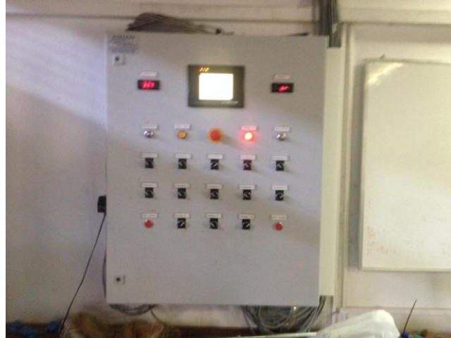
Εικόνα 4-10: Πίνακας ελέγχου (PLC) ταχύρρυθμου συστήματος αναερόβιας χώνευσης PABR
