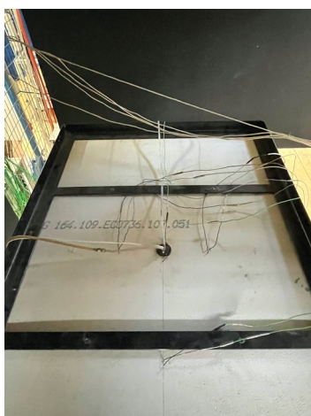
Σχήμα 4.22: Εσωτερικά θερμοστοιχεία οροφής.
