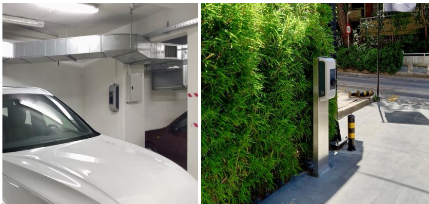
Εικόνα 7 Σταθμός φόρτισης επιτοίχιου τύπου στον χώρο εργασίας (Πηγή: https://www.recharge.gr/work/ )
