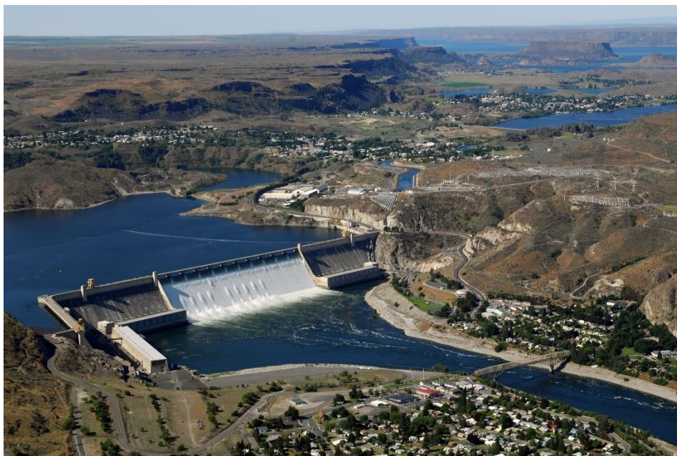
Σχήμα 35: Μεγάλο υδροηλεκτρικό: φράγμα Grand Coulee 6,8 GW, ΗΠΑ. Πηγή: https://usbr.gov/pn/grandcoulee/news/gallery/aerial/1.html
