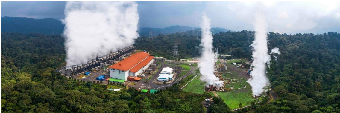
Σχήμα 40: Γεωθερμικό Εργοστάσιο Gunung Salak στην Ινδονησία. Πηγή: https://www.starenergygeothermal.co.id/salak/
