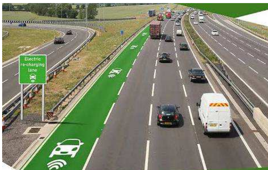
Εικόνα 11. Λωρίδα επαγωγικής δυναμικής φόρτισης σε αυτοκινητόδρομο [7]
