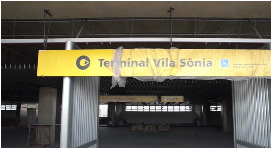
Εικόνα 19. Τερματικός σταθμός Γραμμής 4 -Vila Sonia (Lobo, 2021)
