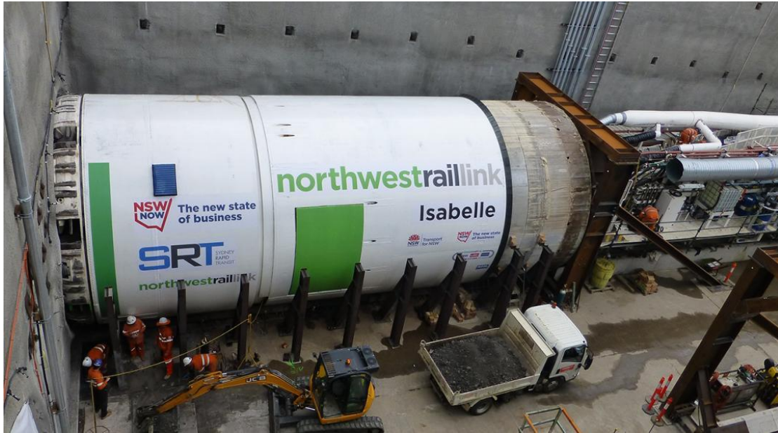
Εικόνα 11. Έναρξη εργασιών για την κατασκευή του Μετρό του Σύδνεϋ (Sydney Metro Northwest) (APP)
