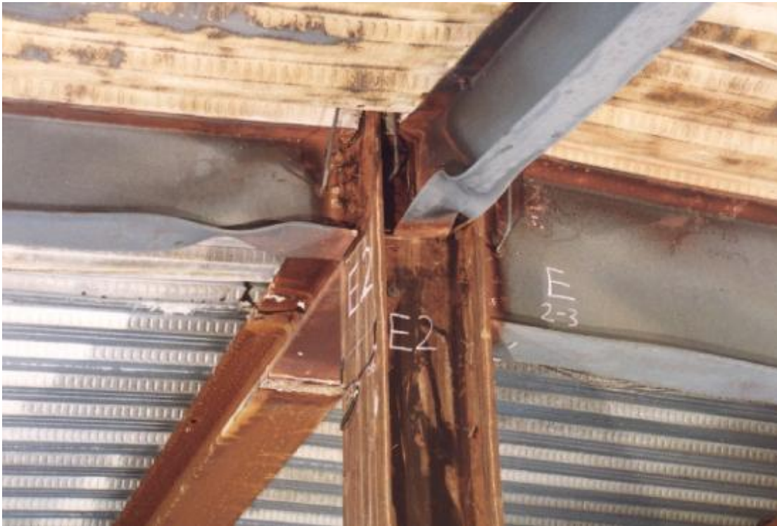
Σχήμα 2.19 Τοπικός λυγισμός στα θλιβόμενα πέλματα δοκού
