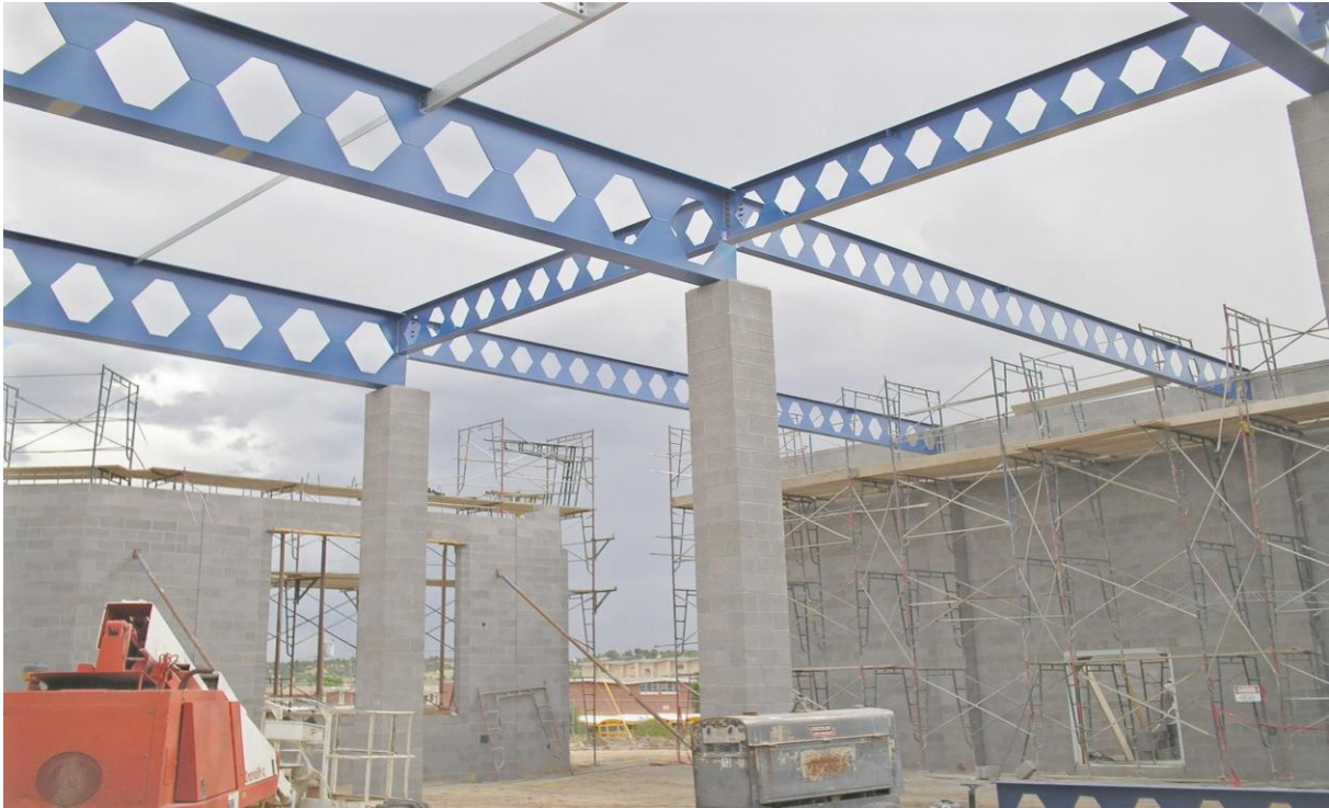
Σχήμα 1.33 Κυφελωτές δοκοί με πολυγωνικές οπές
