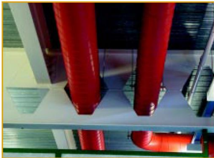
Σχήμα 1.29 Διέλευση αγωγών διαμέσου πολυγωνικών οπών
