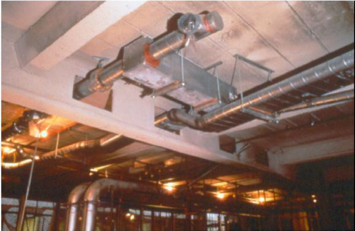
Σχήμα 1.37 Ορθογωνικά ανοίγματα σε κύρια δοκό
