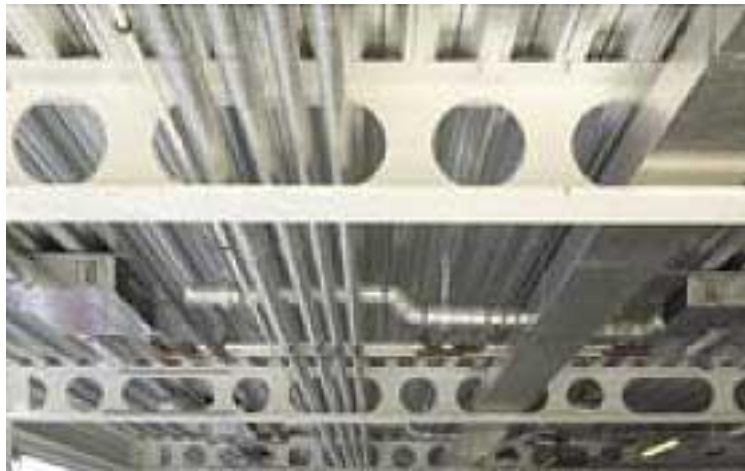
Σχήμα 1.28 Διέλευση πολλών αγωγών διαμέσου επιμηκυμένων ανοιγμάτων (ελλειπτικής μορφής)
