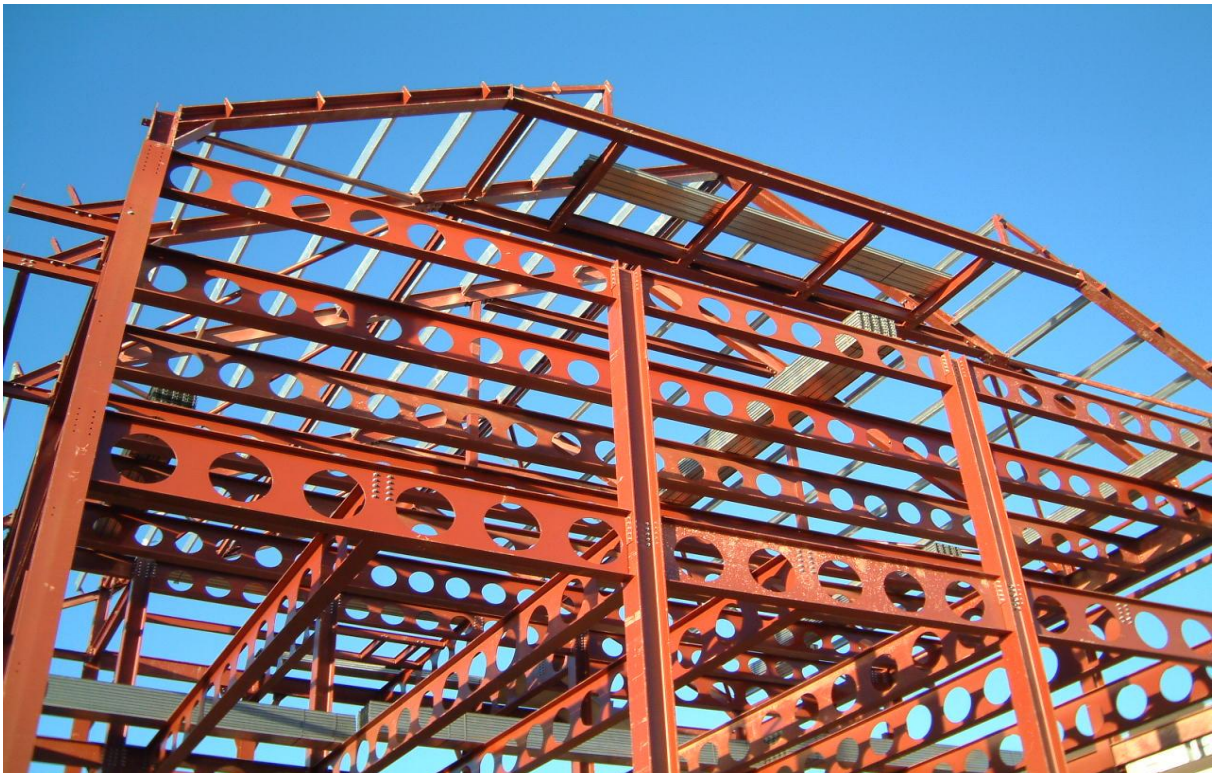
Σχήμα 1.32 Κατασκευή νοσοκομειακής μονάδας, Preston, Μ.Βρετανία
