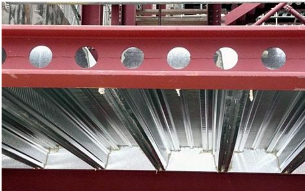
Σχήμα 10.3 Κυψελωτή δοκός στην George IV Bridge, Edinburgh
