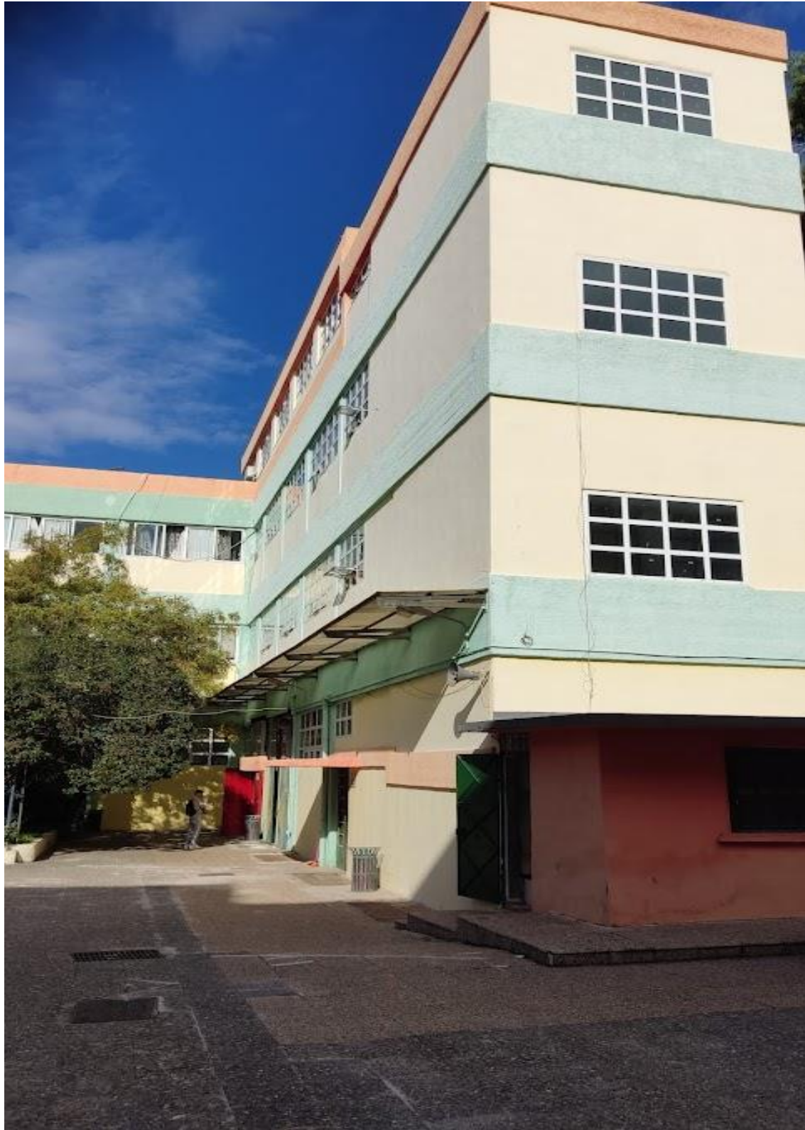
Εικόνα 1: Εξωτερική όψη κτηρίου
