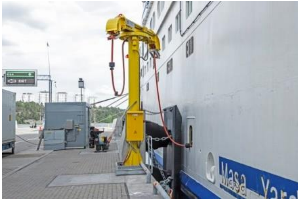
Εικόνα 19: Σύστημα περιέλιξης καλωδίων (safety4sea 2019)
