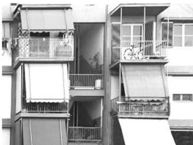
Συγκρότημα εργατικών πολυκατοικιών που σχεδιάστηκε στο Δήμο του Ρέντη από τον Ο.Ε.Κ. το 1955. (Αρχιτέκτονας ήταν ο Άρης Κωνσταντινίδης).
