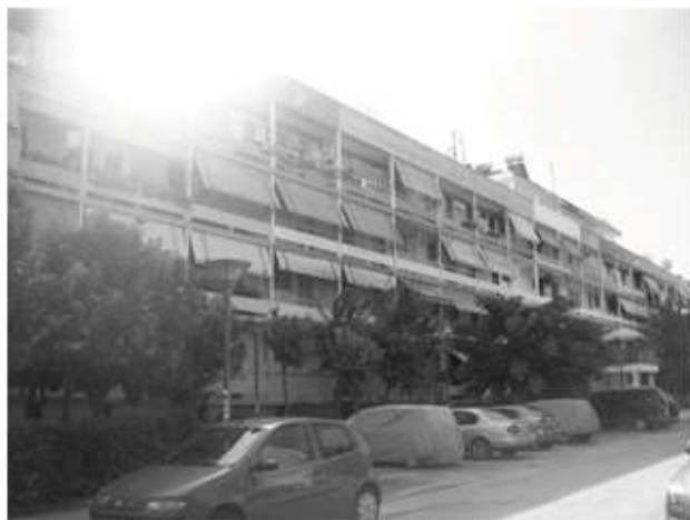
Προσφυγική πολυκατοικία τεσσάρων ορόφων στον Ταύρο (οδός Ερυθρού Σταυρού). Ανεγέρθηκε την περίοδο 1956-1957.
