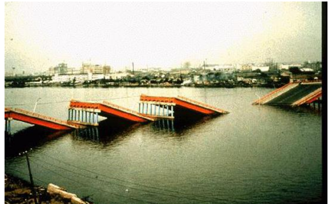
Εικόνα 11 – Πτώση αμφιέρειστων τμημάτων του φορέα της γέφυρας Showa – Ohashi στο σεισμό της Niigata, Ιαπωνία, 1964
