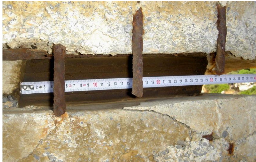
Εικόνα 26 – Οξειδωμένα εφεδρανα πλάτους περί τα 30cm
