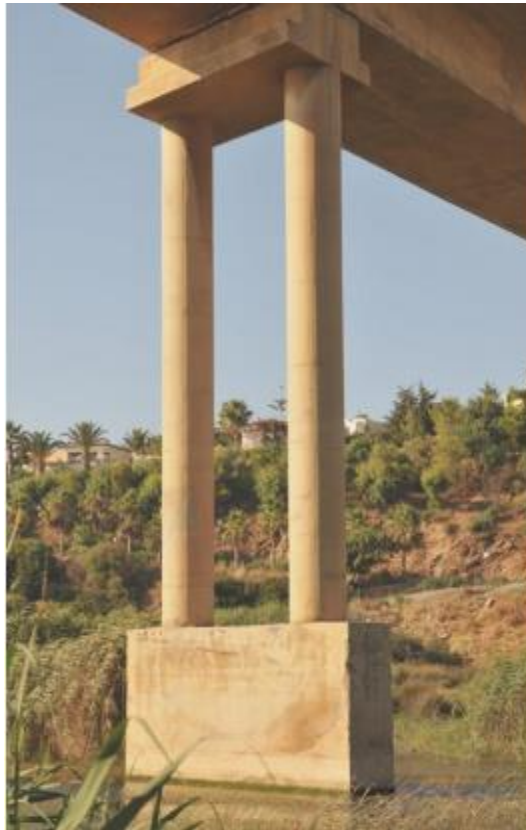
Εικόνα 95 – Όψη βάθρου γέφυρας Γεροποτάμου
