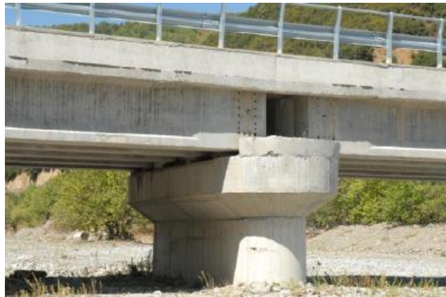
Εικόνα 3 – Αμφιέριστος Φορέας – Γέφυρας Πτελέας, Σπερχειός
