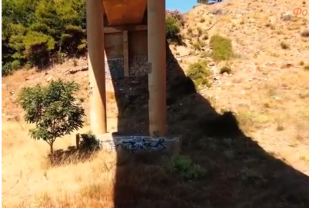
Εικόνα 31 – Όψη βάθρου θεμελιωμένου εντός των γαιών
