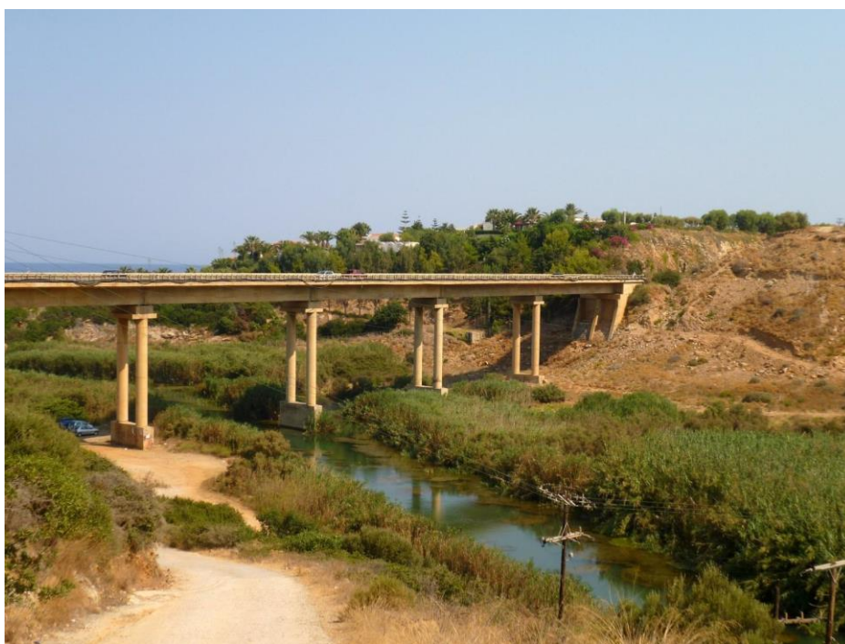
Εικόνα 21 – Γεροπόταμος ποταμός και Γέφυρα
