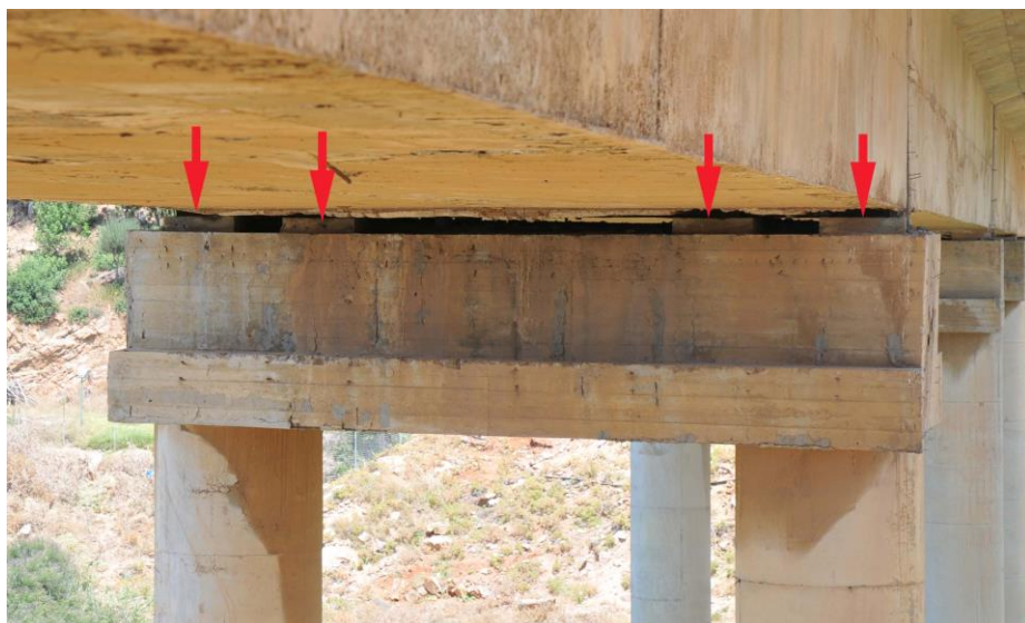
Εικόνα 10 – Σύνδεση βάρου καταστρώματος μέσω εφεδράνων, γέφυρα Γεροποτάμου Κρήτης
