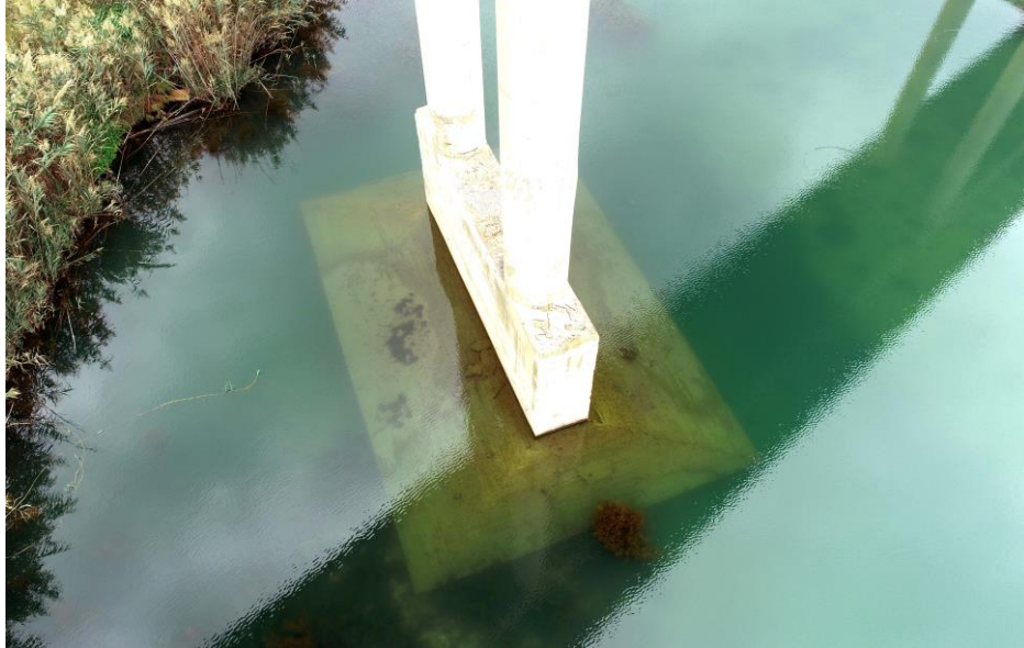
Εικόνα 29 – Βάθρο πλήρως ενσωματωμένο στην κοίτη του ποταμού. Διαφαίνεται το πέδιλο της θεμελίωσης
