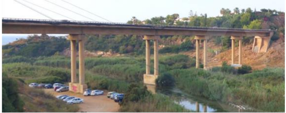
Εικόνα 2 – Αμφιέριστος Φορέας – Γέφυρα Γεροποτάμου Κρήτης
