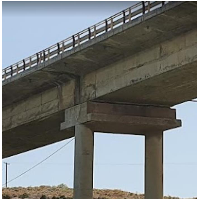
Εικόνα 23 – Δοκός στέψης γέφυρας Γεροποτάμου
