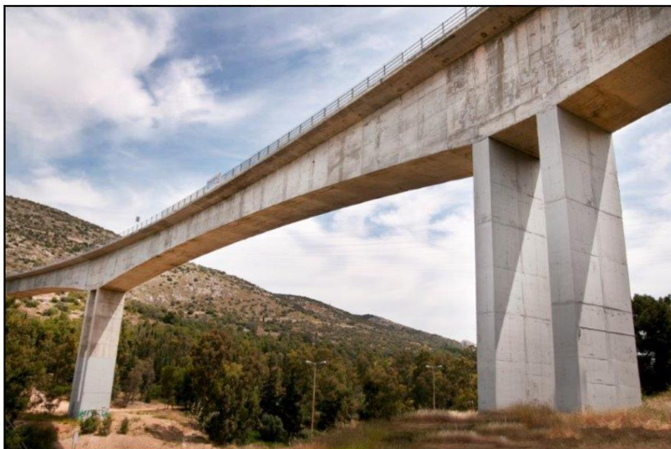
Εικόνα 5 – Σιδηροδρομική Γέφυρα μεταφοράς εμπορευματοκιβωτίων, Χαϊδάρι
