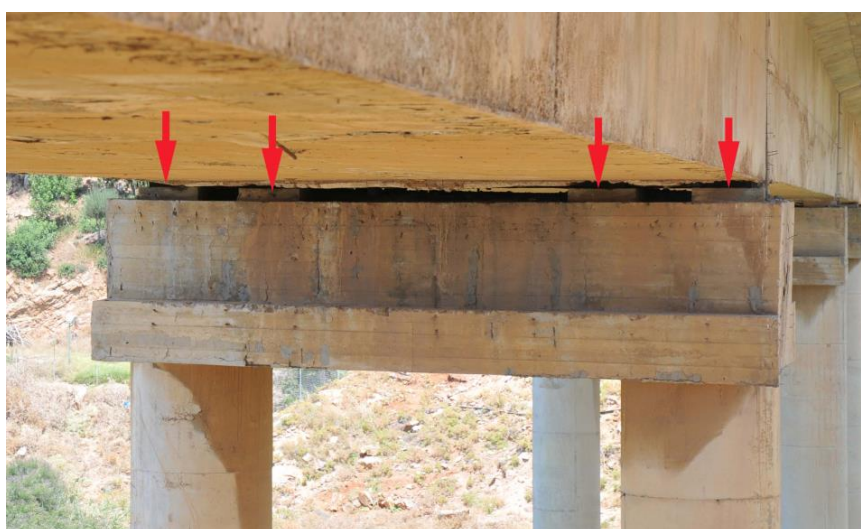
Εικόνα 24 – Τέσσερα εκατέρωθεν εφέδρανα στη δοκό στέψης
