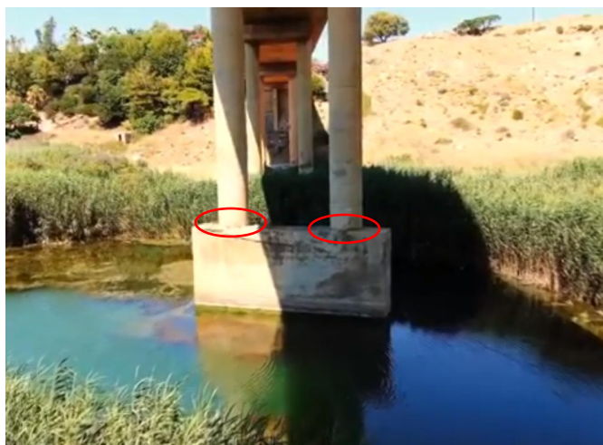
Εικόνα 98 – Προσδιορισμός Πλαστικών Αρθρώσεων στη βάση των κυκλικών υποστλωμάτων
