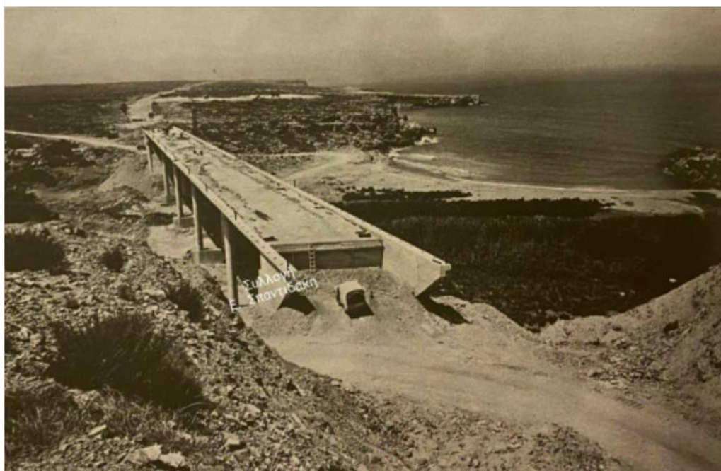
Εικόνα 42 – Φωτογραφία Αρχείου κατά την κατασκευή. Διαφαίνονται τα καλούπια και η σκυροδέτηση
