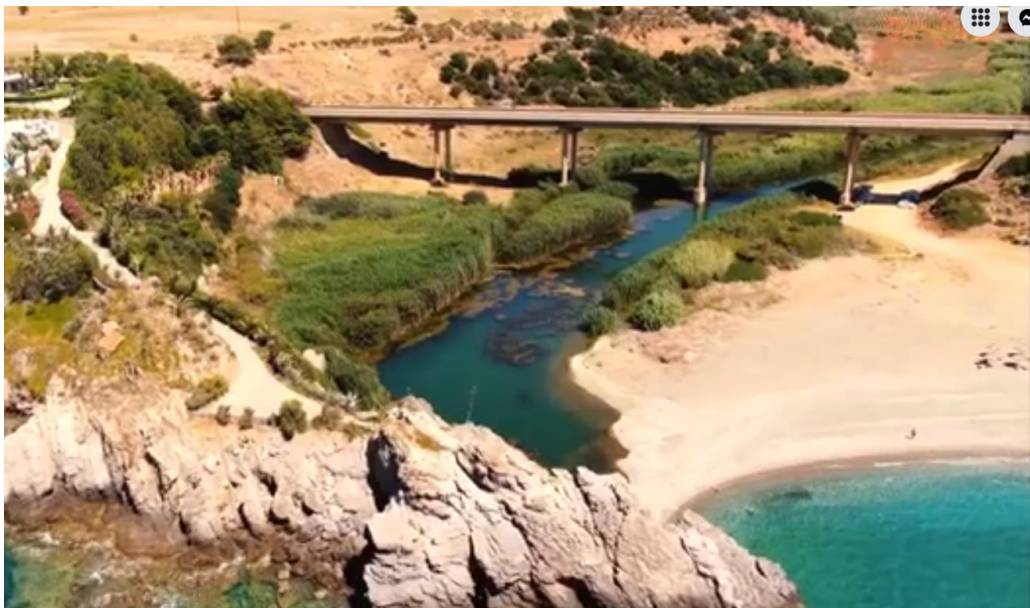
Εικόνα 16 – Βόρεια όψη της Γέφυρας Γεροποτάμου Κρήτης
