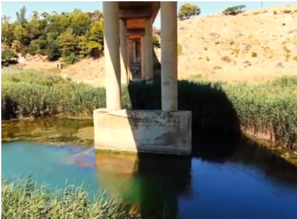
Εικόνα 30 – Όψη του κεντρικού βάθρου εντός ροής
