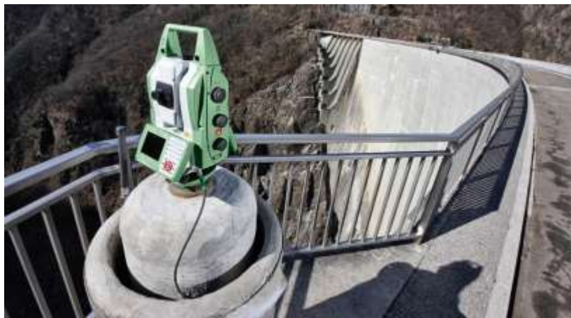
Εικόνα 1.2, Παρακολούθηση μικρομετακινήσεων φράγματος με χρήση ολοκληρωμένου γεωδαιτικού σταθμού.
