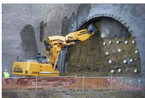
Εικόνα 4.3.1 Εκσκαφή σήραγγας (1) με εκσκαπτικό κάδο (2) με υδραυλική σφύρα (Εικόνα από το διαδίκτυο)
