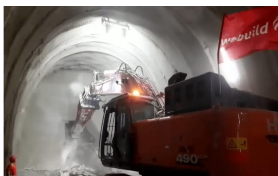
Εικόνα 4.3.1 Εκσκαφή σήραγγας (1) με εκσκαπτικό κάδο (2) με υδραυλική σφύρα (Εικόνα από το διαδίκτυο)
