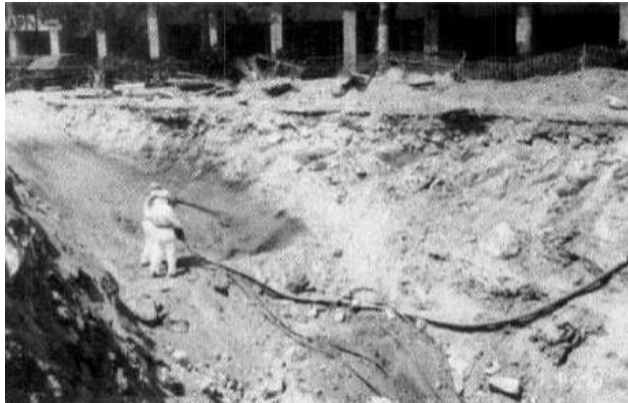
Εικόνα 3.6.3 Κατάρρευση τμήματος εδάφους στη πλατεία Καραϊσκάκη. (ΤΕΕ, 2001)
