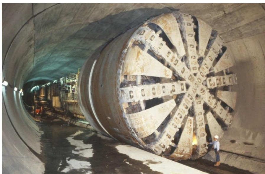
Εικόνα 3.2.4 Μηχανή ολομέτωπης κοπής SM-V2, Μετρό της Αθήνας – NFM-Mitsubishi (Κουκουτάς Σ., 2015)
