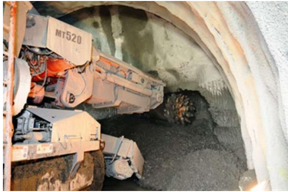
Εικόνα 4.3.2 Εκσκαφή σήραγγας με φρέζα (Εικόνα από το διαδίκτυο)
