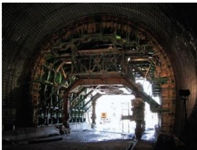
Εικόνα 4.2.10 Κατασκευή τελικής επένδυσης σήραγγας. (Κωμοδρόμος, Α.)
