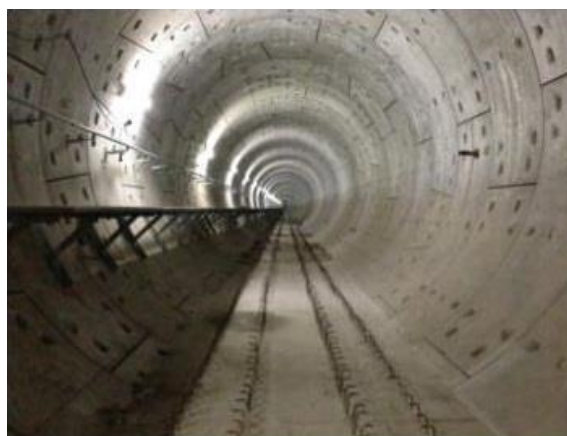
Εικόνα 3.1 Σήραγγα διανοιχθείσα με μηχανή ολομέτωπης κοπής (Nicholas P., 2019).
