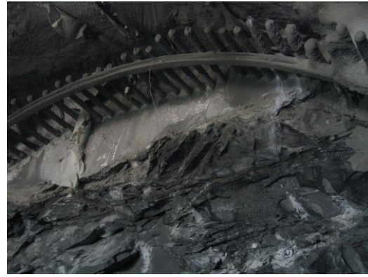
Εικόνα 4.2.7 (1)Δοκοί προπορείας (2) Ελαφρά βλήτρα προπορείας. (Μαρίνος Β., 2021)
