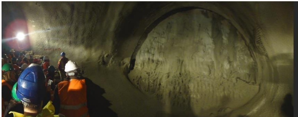
Εικόνα 4.2.8 Κλείσιμο δακτυλίου εκσκαφής. (Μαρίνος Β.,2021)
