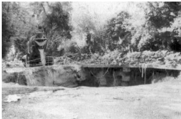
Εικόνα 3.6.5 Πλήρωση της κοιλότητας με σκυρόδεμα στο Εθνικό Κήπο. (ΤΕΕ, 2001)
