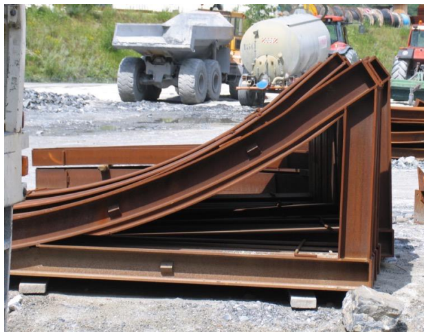
Εικόνα 4.2.6 Άκαμπτο πλαίσιο με ελεφαντοπόδαρο. (Μαρίνος Β., 2021)
