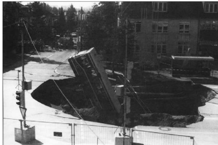
Εικόνα 4.6.5 Δημιουργία κρατήρα λόγω κατάρρευσης της σήραγγας, Μόναχο 1994. (Masosonore, M., 2018)
