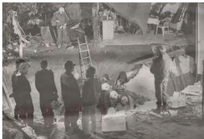
Εικόνα 3.6.9 Κατάρρευση κτισμάτων στην περιοχή διάνοιξης λόγω ανεξέλεγκτων καθιζήσεων. (Fonseca et. al., 2016)
