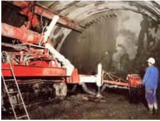
Εικόνα 4.2.7 (1)Δοκοί προπορείας (2) Ελαφρά βλήτρα προπορείας. (Μαρίνος Β., 2021)
