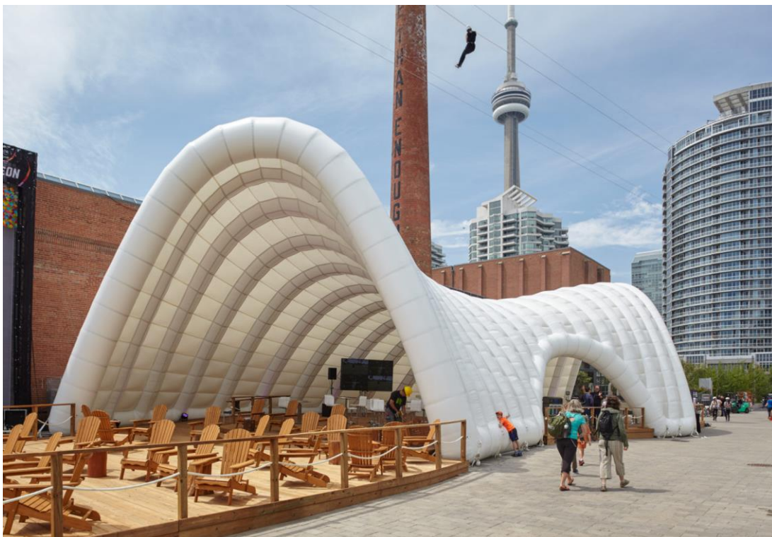
Εικόνα 1-5: Ontario Celebration Zone, πνευματική κατασκευή στο Οντάριο του Καναδά [ www.blackwell.ca ]
