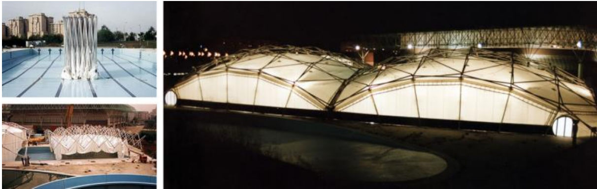
Εικόνα 1-9: Πτυσσόμενο στέγαστρο της πισίνας της Σεβίλλης [Escrig, 2012]
