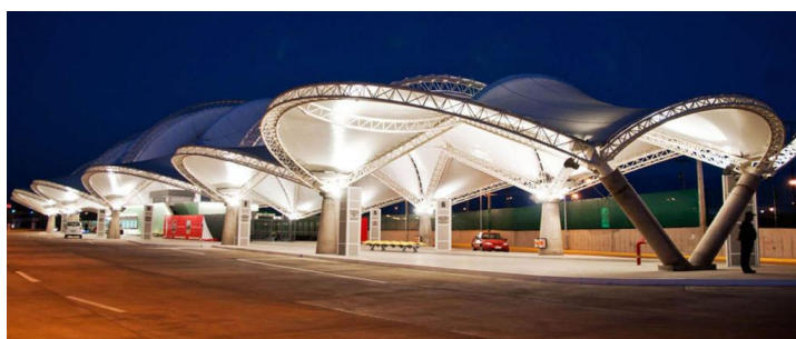
Εικόνα 1-10: Επικάλυψη στεγάστρου μέσω εφελκόμενων μεμβρανών [www.alm-tmsl.com]
