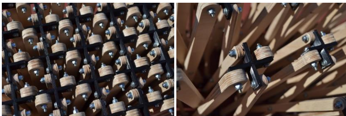
Εικόνα Γ-4: Άποψη των συνδέσεων μεταξύ των ψαλιδωτών στοιχείων
