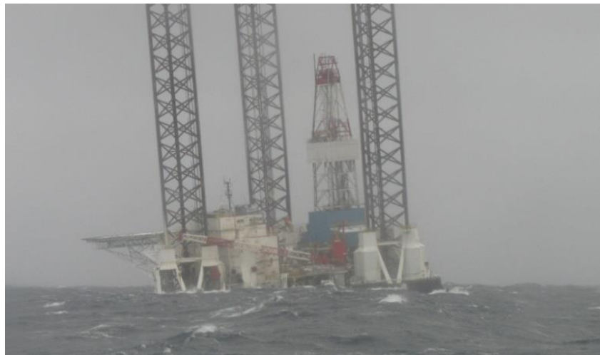
Εικόνα 21: Η πλατφόρμα Kolskaya 21
