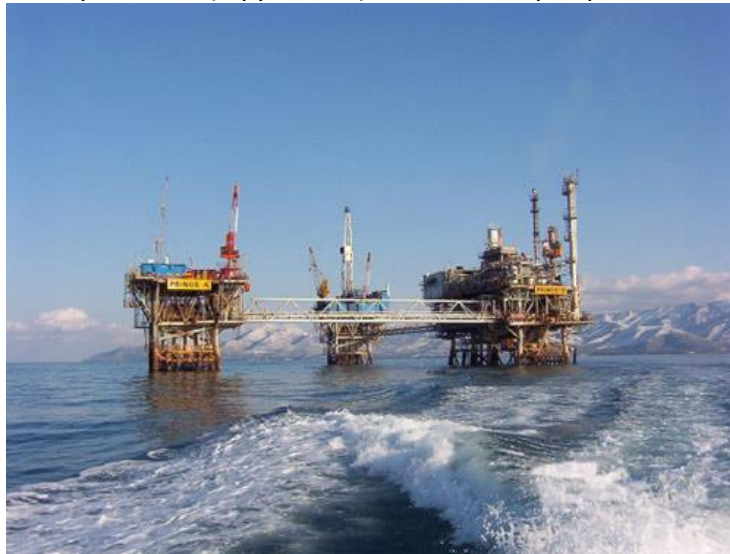
Εικόνα 31: Οι πλατφόρμες Πρίνος 1 και Πρίνος 2 στη περιοχή μεταξύ Καβάλας-Θάσου στο κοίτασμα Πρίνος 31
