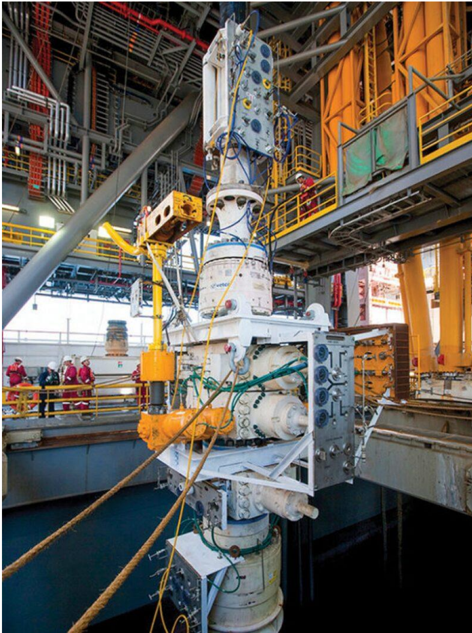
Εικόνα 50: Το capping device που τοποθετήθηκε στο Macondo 48
