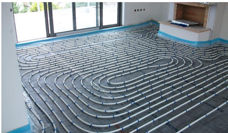
Εικόνα 3.12: Διαδρομή σωληνώσεων ενδοδαπέδιας θέρμανσης [6].
