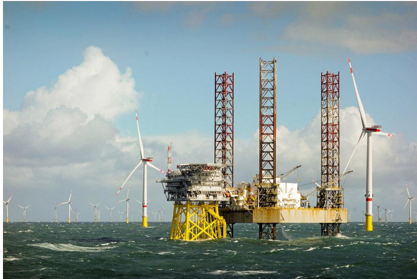
Εικόνα 2.2 : Υπεράκτια πλατφόρμα άντλησης καυσίμων που ηλεκτροδοτείται από υπεράκτιο αιολικό πάρκο.
