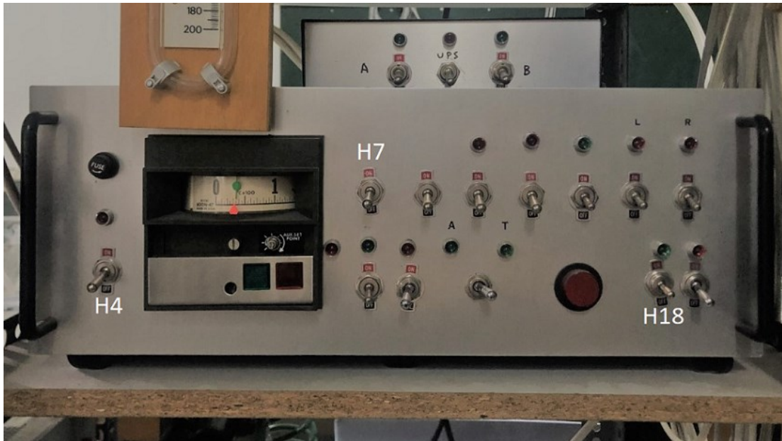
Εικόνα 5.6: Ηλεκτρικός - Ηλεκτρονικός πίνακας ελέγχου θαλάμου "Α"
