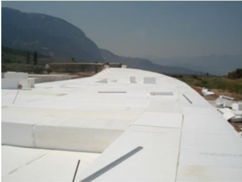
Εικόνα 3.1: Τοποθέτηση μπλοκ EPS σε εργοτάξιο του αυτοκινητόδρομου ΠΑΘΕ στη θέση Θερμοπούλες (2008)
