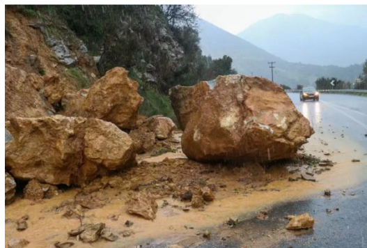
Εικόνα 2.3: (α) Σχηματική απεικόνιση ανατροπής βράχων, (β) Ανατροπή βράχων στον Β.Ο.Α.Κ, Κρήτη
