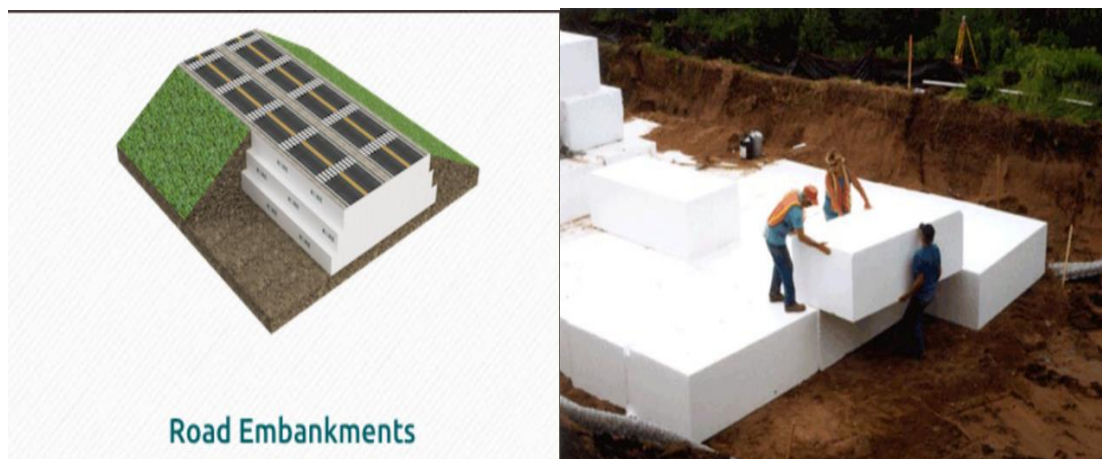
Εικόνα 4.3: (α) Διατομή οδικού τμήματος με γεωαφρό EPS, (β) Τοποθέτηση μπλοκ EPS για την κατασκευή οδικού επιχώματος.
