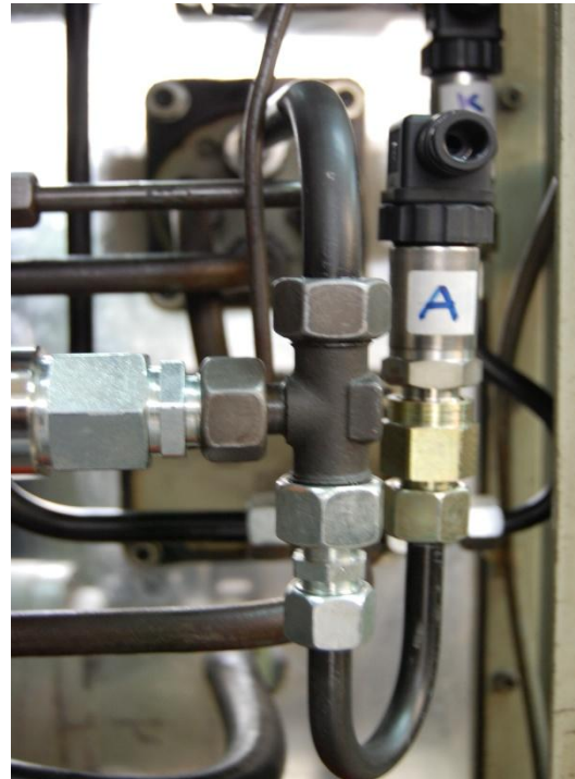
Εικόνα 4.8: Μεταλλάκτες πίεσης SEN-8601/2 A115 (KOBOLD Messring GmbH).
