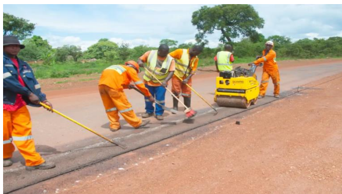
Εικόνα 4: Ανοικοδόμηση δρόμου στη Ζάμπια
