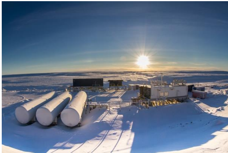
Εικόνα 9: Εγκαταστάσεις αποθήκευσης ενέργειας της TUGLIQ (εγκατάσταση υδρογόνου, δοχείο μπαταρίας και σφόνδυλος)
