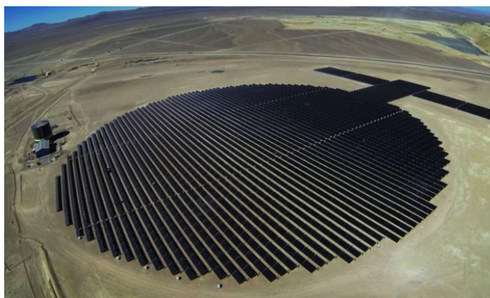
Εικόνα 11: Ο θερμικός ηλιακός σταθμός Elvira Solar της Codelco (Energía Llaima Solar, n.d.)
