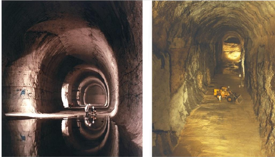
Εικόνα 2.5: Υπόγειο άνοιγμα με τη μέθοδο θαλάμων και στύλων (αριστερά), Σύγχρονοι υπόγειοι θάλαμοι (δεξιά) (Vaskou, 2018)
