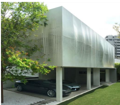
Εικόνα 4. Εξωτερική επικάλυψη κτιρίου από αλουμίνιο
