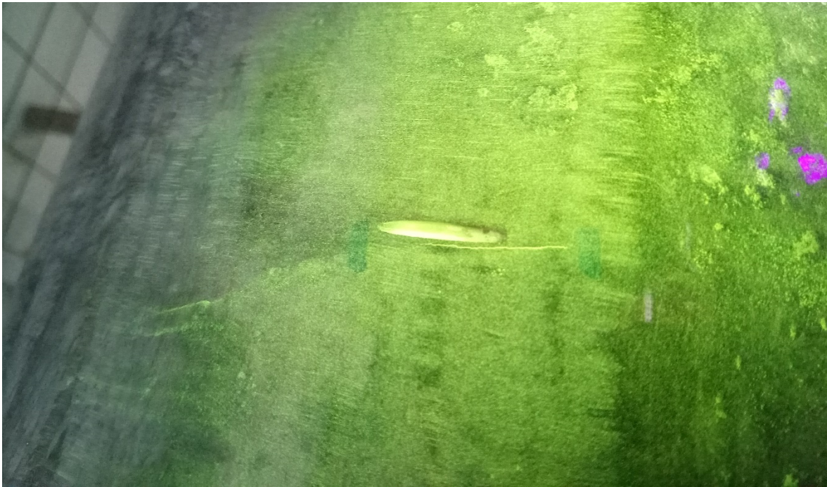
Εικόνα 3.1: Ρωγμή μήκους 20mm
