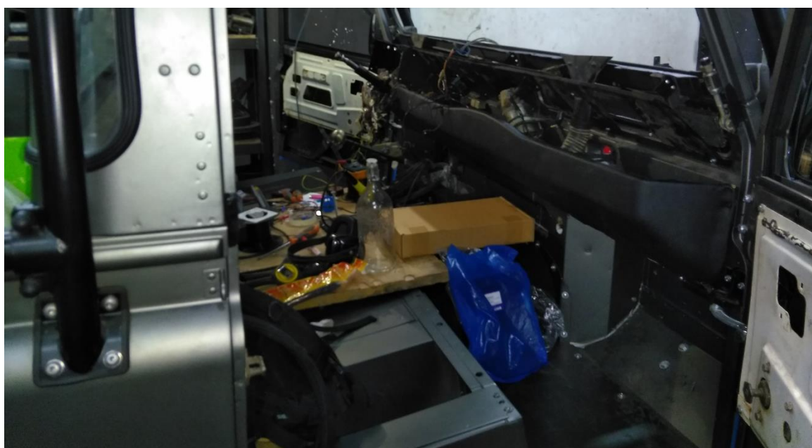
Τοποθέτηση του κάτω τμήματος του ταμπλό μετά από επιμήκυσή του
