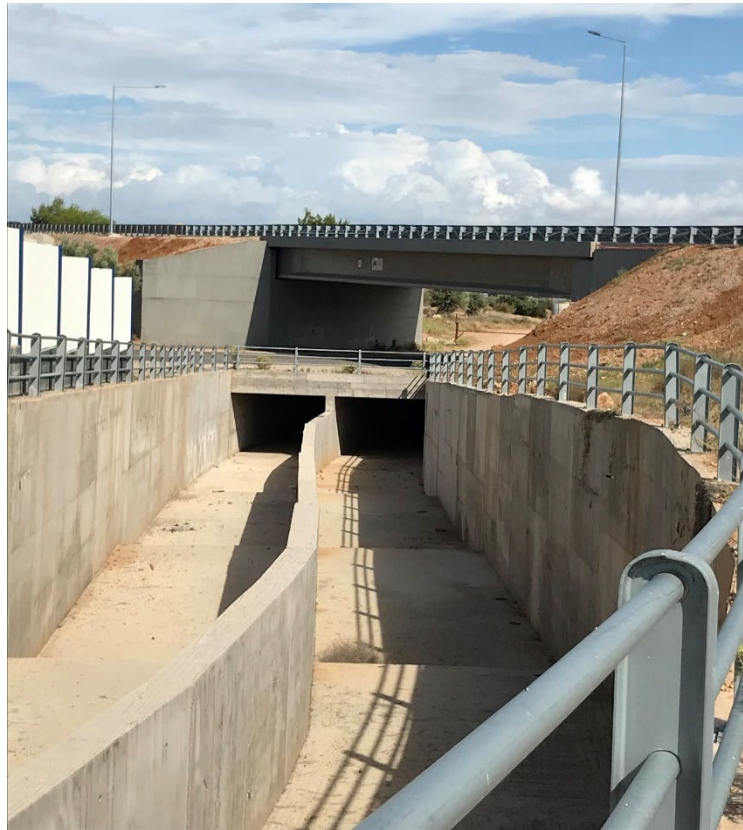
Εικόνα 4.2-3. Δίδυμος ορθογωνικός αγωγός με πτώσεις
