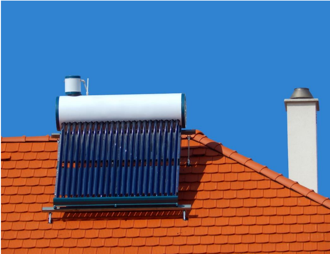
Σχήμα 35. Ηλιακός συλλέκτης για θέρμανση νερού [32].
