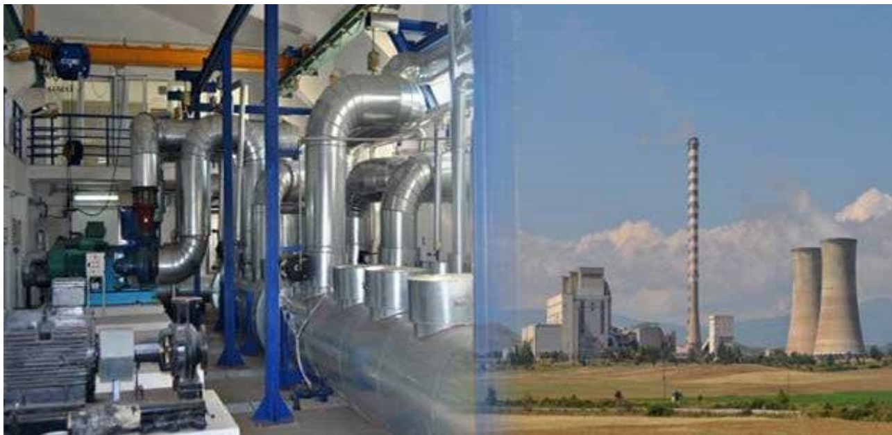
Σχήμα 43. Τηλεθέρμανση Πτολεμαΐδας, αριστερά οι σωληνώσεις και δεξιά ο ΑΗΣ [40].
