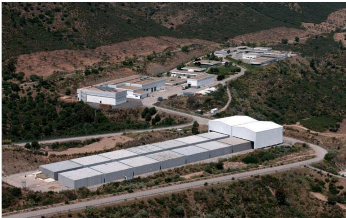
Εικόνα 2: Εγκατάσταση Διάθεσης Ραδιενεργών Αποβλήτων El-Cabril
