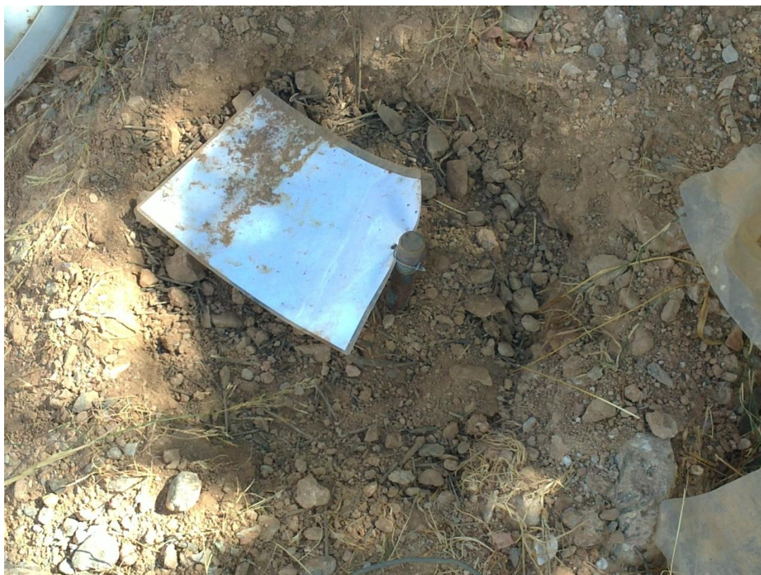
Εικόνα 6.13: Το ηλεκτρόδιο 6 μετά την πλήρωση με χώμα.
