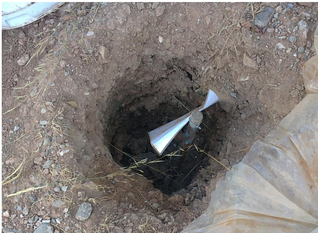
Εικόνα 6.12: Το ηλεκτρόδιο 6 πριν την πλήρωση με χώμα.
