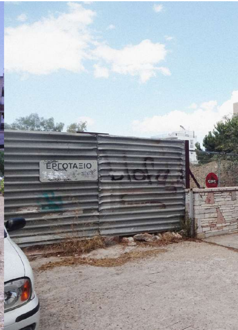
το μέτωπο από την πλευρά των κτηρίων που βρίσκονται εντός της περιοχής: λαμαρίνες, απαγόρευση πρόσβασης
